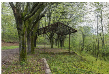
Vestiges des promenoirs d'Ernest Panz remontés sur le site de Pougues-Bellevue. Phot. Pierre-Marie Barbe-Richaud IVR26_20195800242NUC4A
