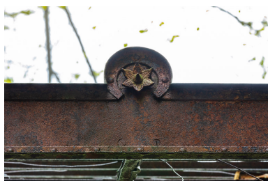
Vestiges des promenoirs d'Ernest Panz remontés sur le site de Pougues-Bellevue. Phot. Pierre-Marie Barbe-Richaud IVR26_20195800244NUC4A
