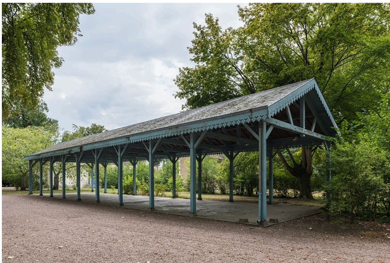
Allée couverte après reconstruction.
