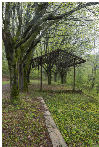
Vestiges des promenoirs d'Ernest Panz remontés sur le site de Pougues-Bellevue. Phot. Pierre-Marie Barbe-Richaud IVR26_20195800243NUC4A
