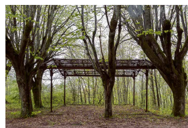
Vestiges des promenoirs d'Ernest Panz remontés sur le site de Pougues-Bellevue. Phot. Pierre-Marie Barbe-Richaud IVR26_20195800241NUC4A
