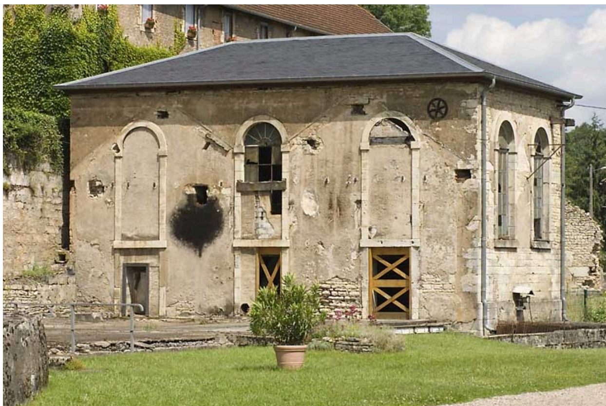
Façade est de la salle des machines.
