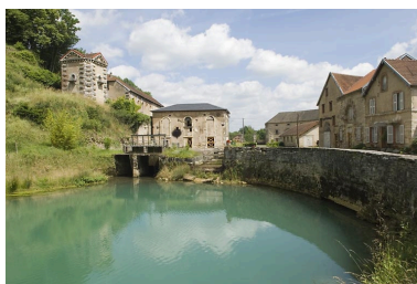
Source de la Baignotte et salle des machines. Phot. Jérôme Mongreville IVR43_20087000649NUC2A
