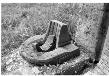
Modèle du cadre de sortie du cubilot. Phot. Dominique Dominguez IVR43_19817000044Z
