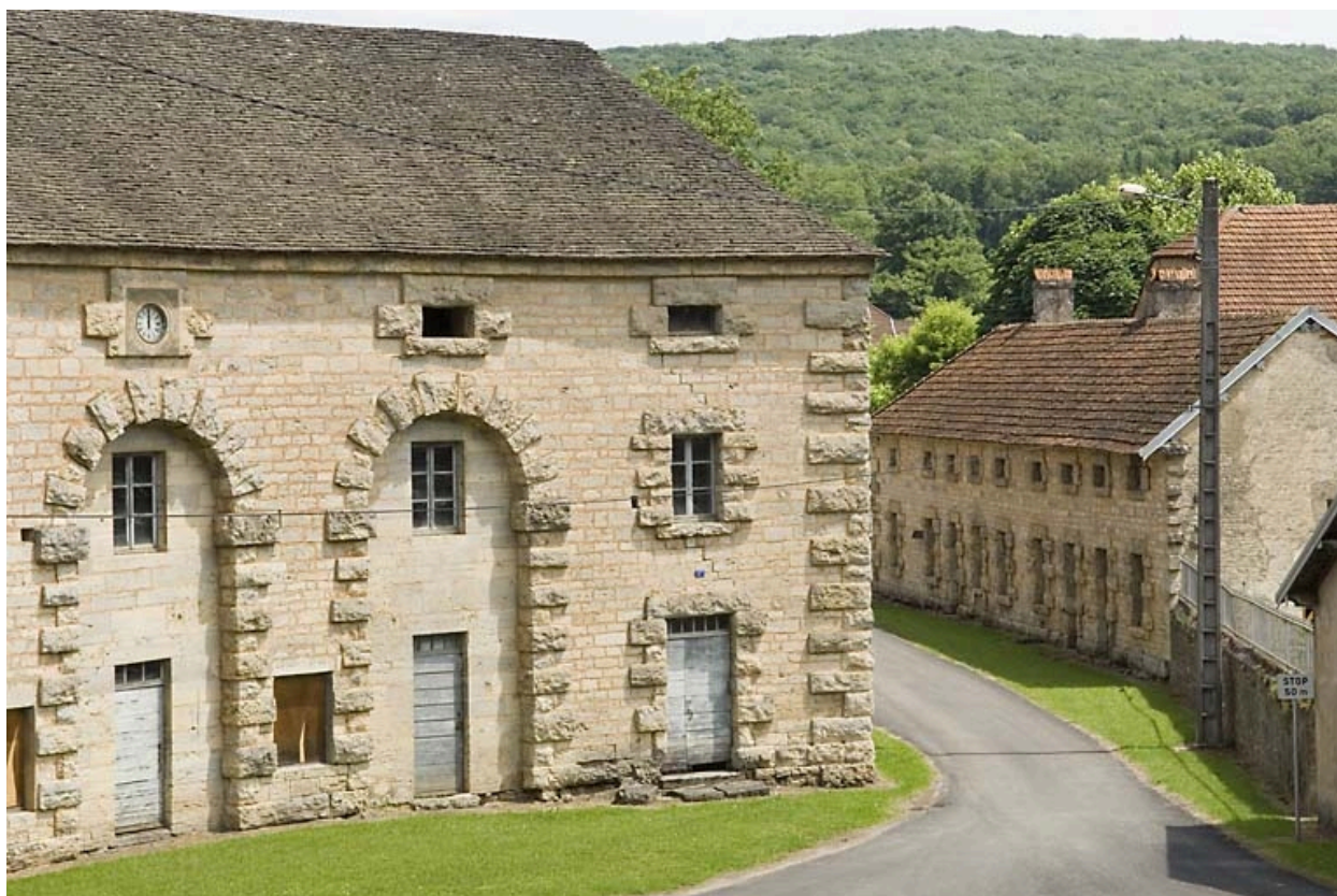
Magasin en quart de cercle et logement ouvrier est bordant la rue.
