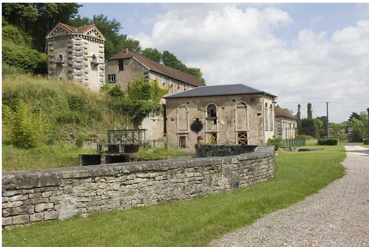
Pigeonnier, halle à charbon et salle des machines depuis l'est.
