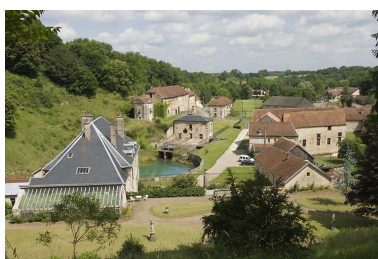
Vue d'ensemble du site depuis l'est. Phot. Jérôme Mongreville IVR43_20087000646NUC2A
