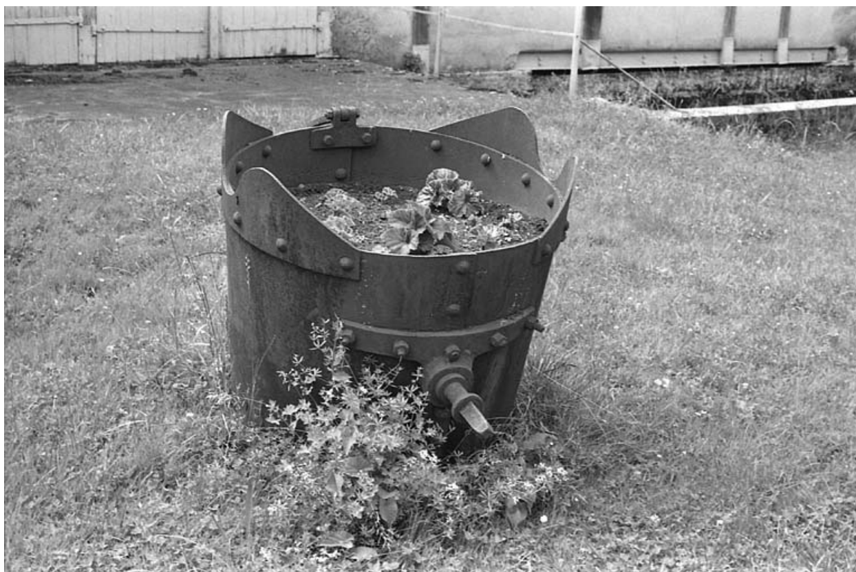
Poche de coulée du haut fourneau (250 kg).
