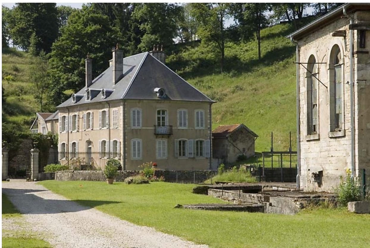
Logement patronal vu de trois quarts.
