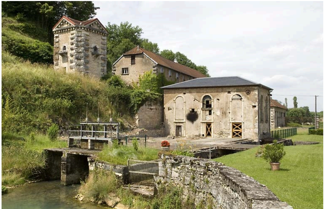
Pigeonnier, halle à charbon et salle des machines depuis l'est.
