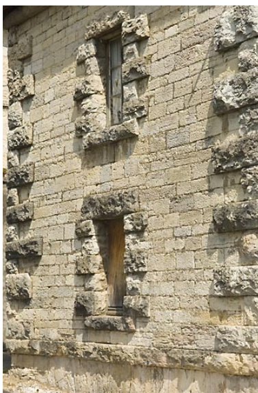
Travée de façade du logement ouvrier ouest. Phot. Jérôme Mongreville IVR43_20087000641NUC2A
