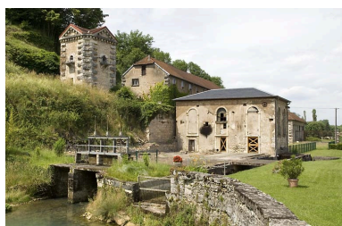
Pigeonnier, halle à charbon et salle des machines depuis l'est. Phot. Jérôme Mongreville IVR43_20087000665NUC2A
