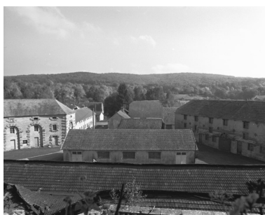
Vue plongeante depuis la halle à charbon en 1989. Phot. Yves Sancey IVR43_19897000696X
