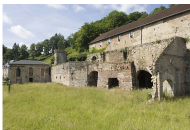
Vestiges du haut fourneau. Au premier plan : emplacement de l'atelier de fonderie.
