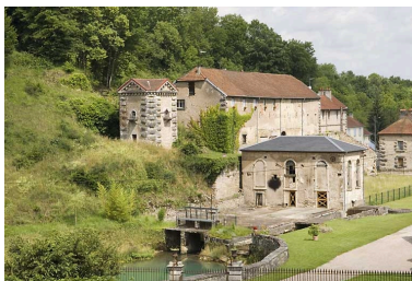
Vue d'ensemble des bâtiments de production depuis l'est. Phot. Jérôme Mongreville IVR43_20087000644NUC2A
