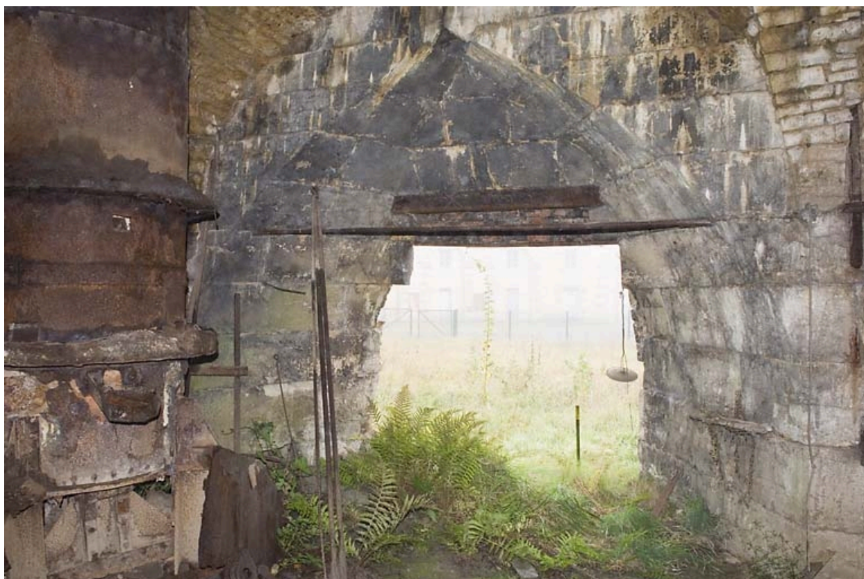
Cubilot est et embrasure appareillée (vestige du haut fourneau).
