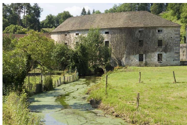
Le magasin en quart de cercle vu depuis le nord-ouest. Phot. Jérôme Mongreville IVR43_20087000628NUC2A
