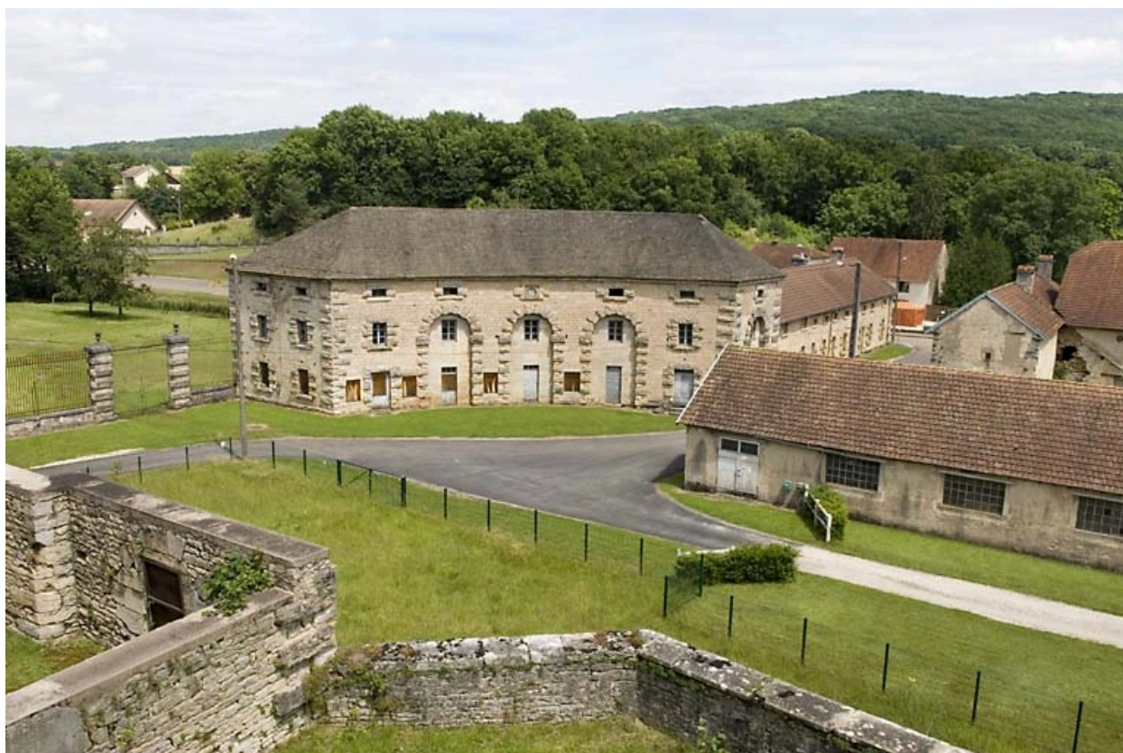
Vue plongeante depuis le sud.
