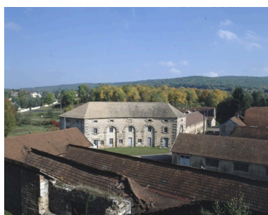
Vue plongeante sur le magasin en quart de cercle en 1989. Phot. Yves Sancey IVR43_19897000701XA
