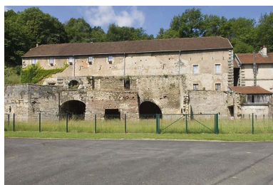
Halle à charbon et vestiges du haut fourneau. Vue de face. Phot. Jérôme Mongreville
