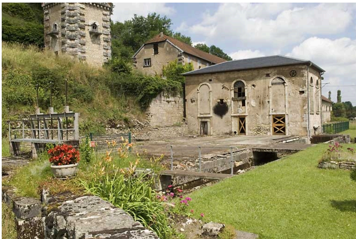
Salle des machines depuis l'est.
