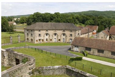
Vue plongeante depuis le sud. Phot. Jérôme Mongreville IVR43_20087000660NUC2A
