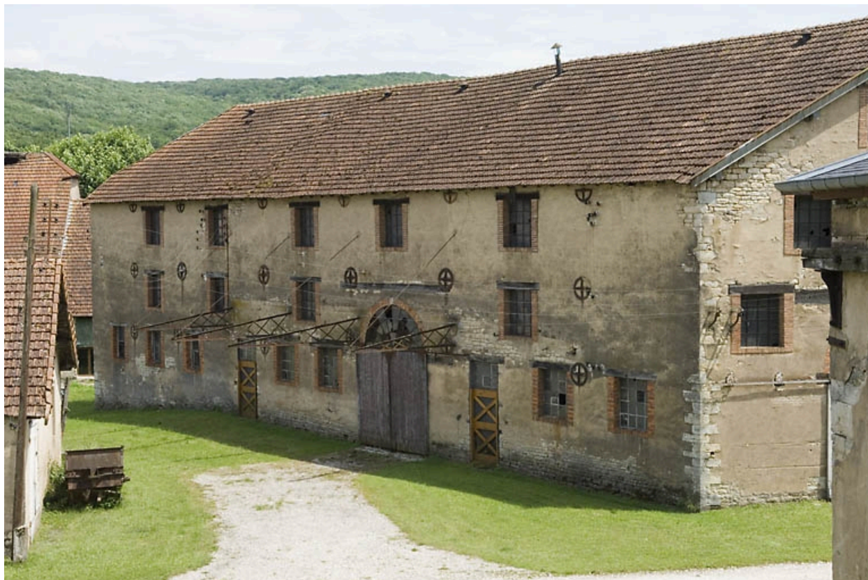
Façade ouest du magasin industriel (fonderie).
