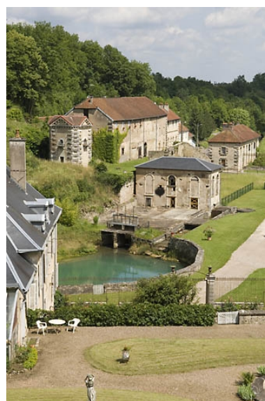
Vue plongeante depuis le parc du logement patronal, à l'est. Phot. Jérôme Mongreville IVR43_20087000645NUC2A
