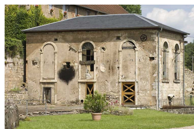
Façade est de la salle des machines. Phot. Jérôme Mongreville IVR43_20087000653NUC2A
