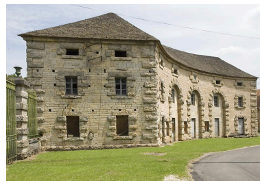
Magasin en quart de cercle depuis le sud-est. Phot. Jérôme Mongreville IVR43_20087000655NUC2A
