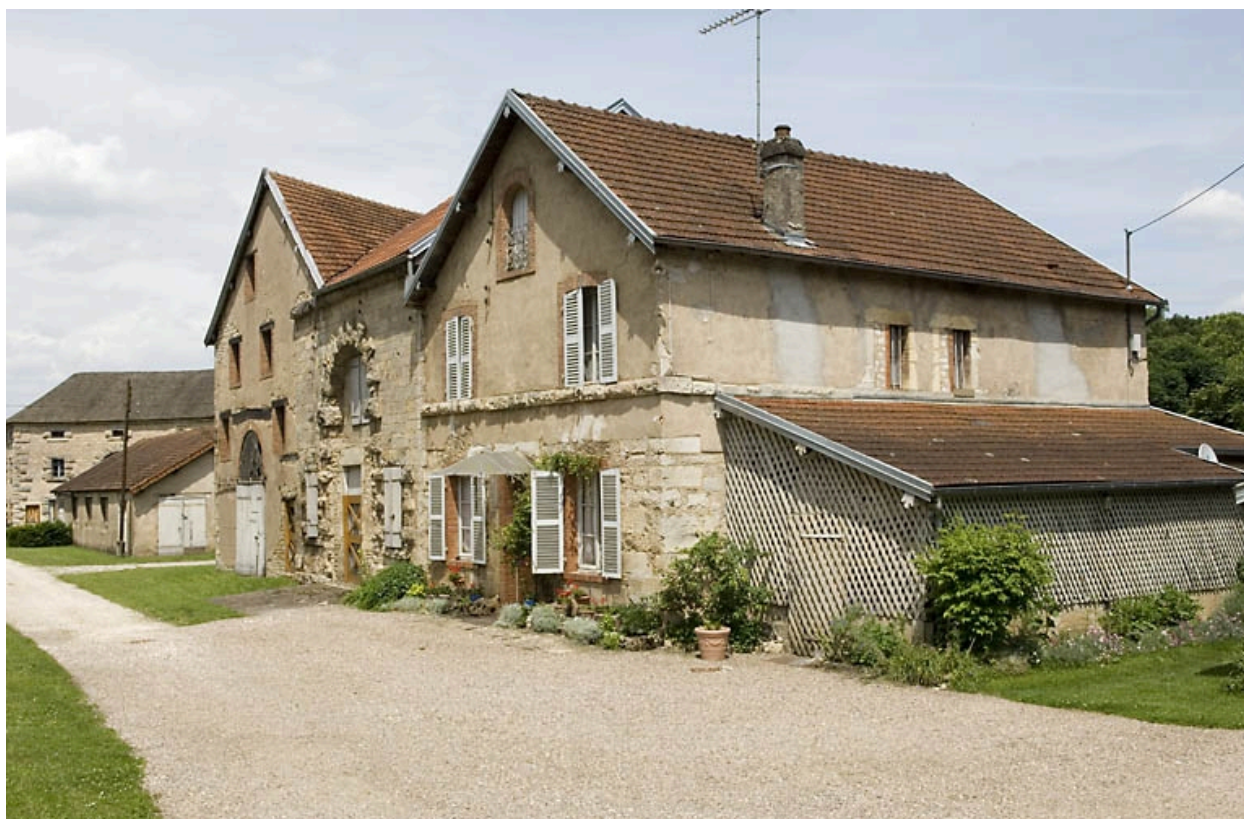
Magasin industriel, écurie et logement depuis le sud-est.
