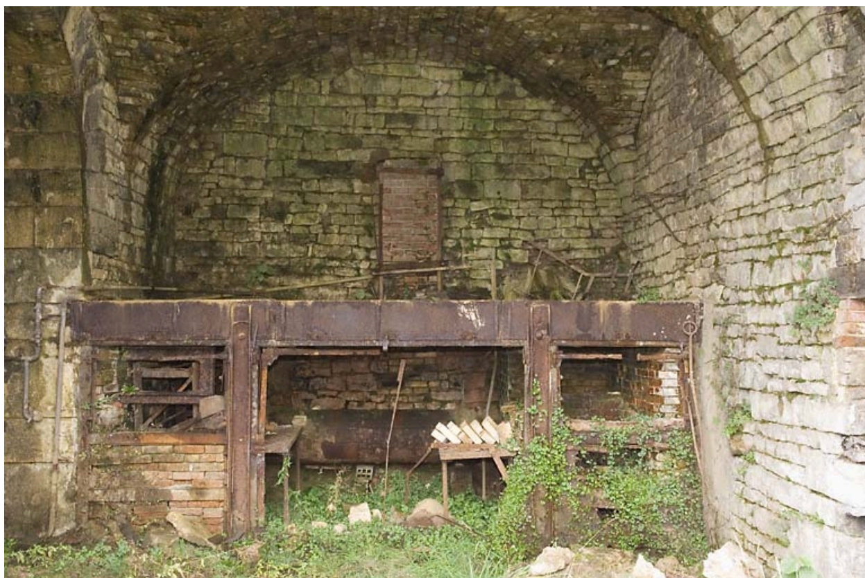
Salle des cubilots. Vestiges d'un four (?).
