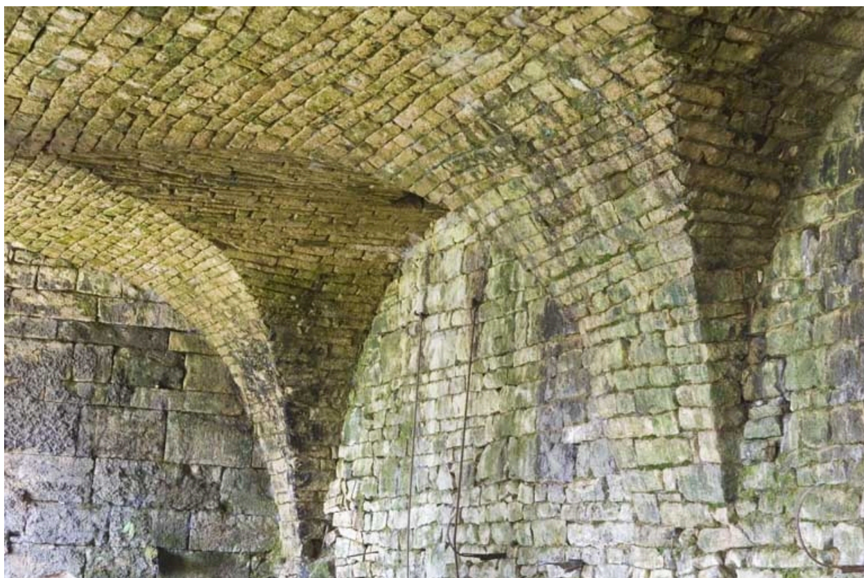
Salle des cubilots. Détail des voûtes d'arêtes.
