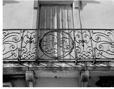
Façade antérieure, détail du balcon. Phot. Yves Sancey IVR43_19833900636X
