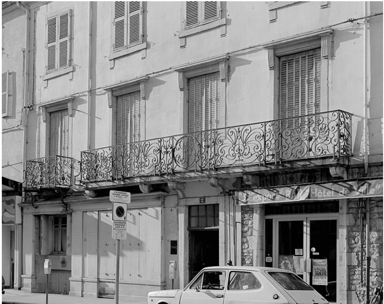
Façade antérieure, vue partielle.
