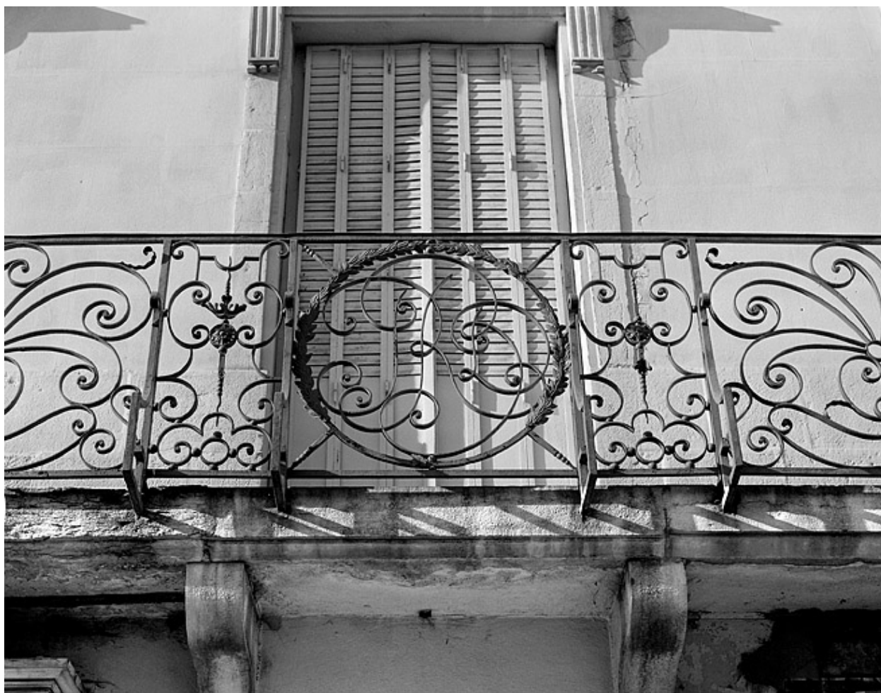
Façade antérieure, détail du balcon.
