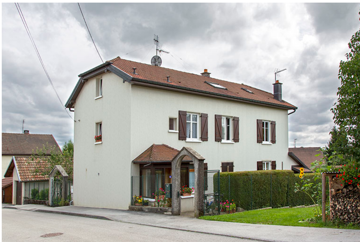
Façades antérieure et latérale gauche.
