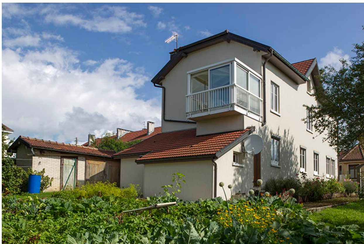
Façades postérieure et latérale droite.
