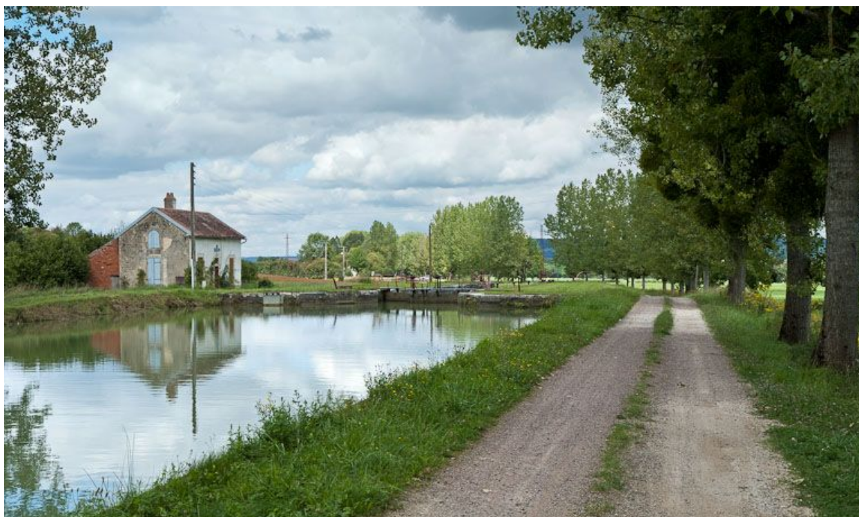
Vue du site d'écluse depuis l'amont.
