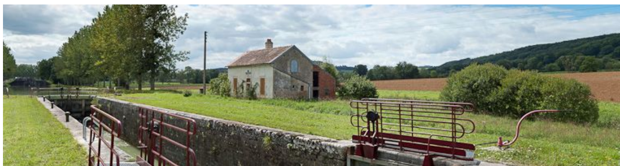
Vue d'ensemble du site d'écluse.
