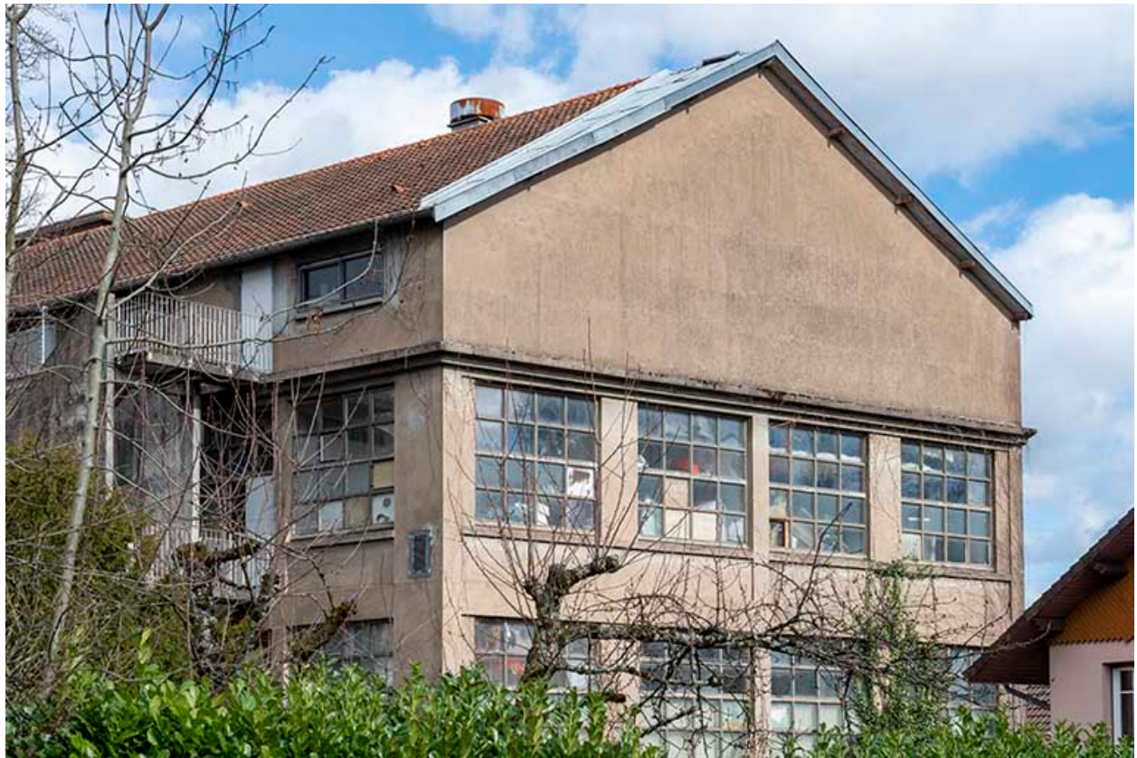
Pignon sud de l'entrepôt industriel.
