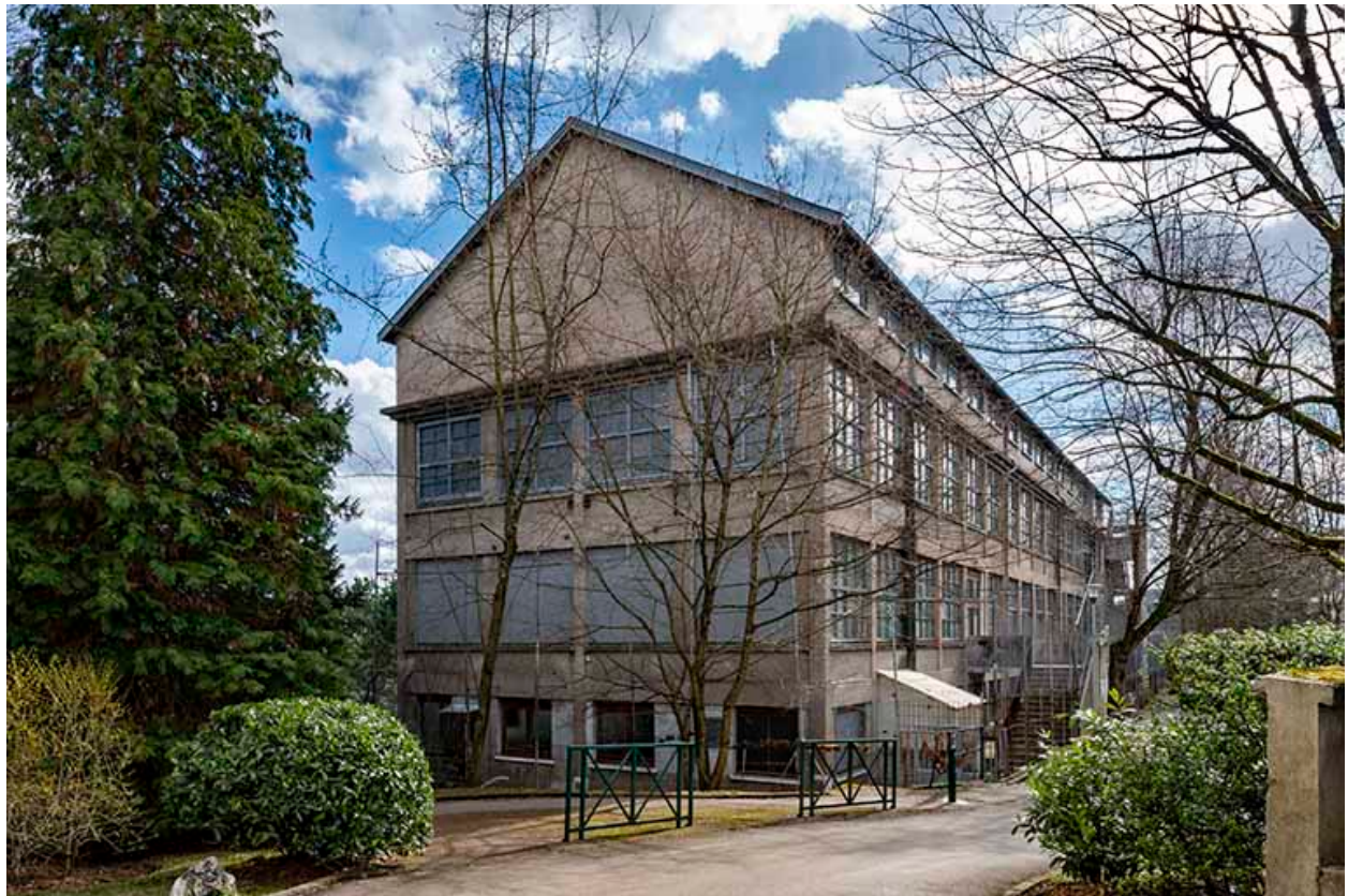
Entrepôt industriel, vu depuis le nord.
