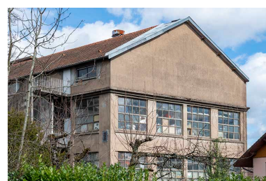
Pignon sud de l'entrepôt industriel. Phot. Jérôme Mongreville IVR43_20192500127NUC4A
