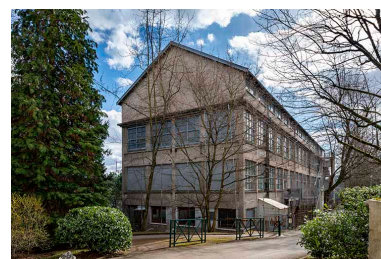
Entrepôt industriel, vu depuis le nord. Phot. Jérôme Mongreville IVR43_20192500124NUC4A
