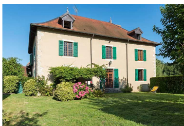
Façade sur jardin Phot. Sonia Dourlot IVR43_20167001131NUC4A
