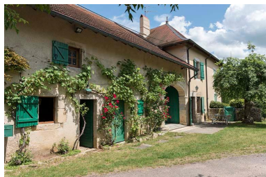
Espace agricole et partie habitation dans son prolongement Phot. Sonia Dourlot IVR43_20167001137NUC4A
