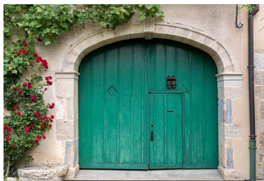
Vue de la porte charretière Phot. Sonia Dourlot IVR43_20167001135NUC4A
