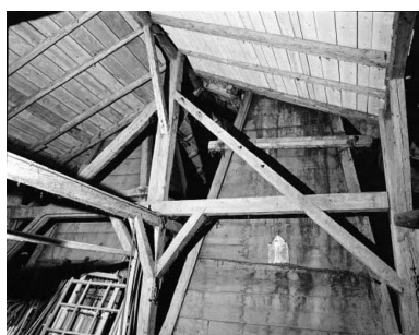
Intérieur en 1977, combles : ferme de charpente et hottes des "tués". Phot. Yves Sancey IVR43_19772500334X
