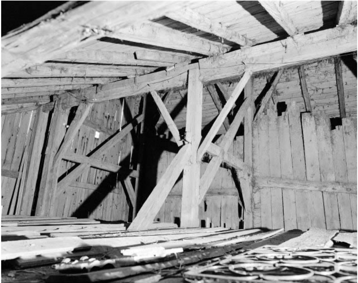
Intérieur en 1977, combles : fermes de charpente postérieures.
