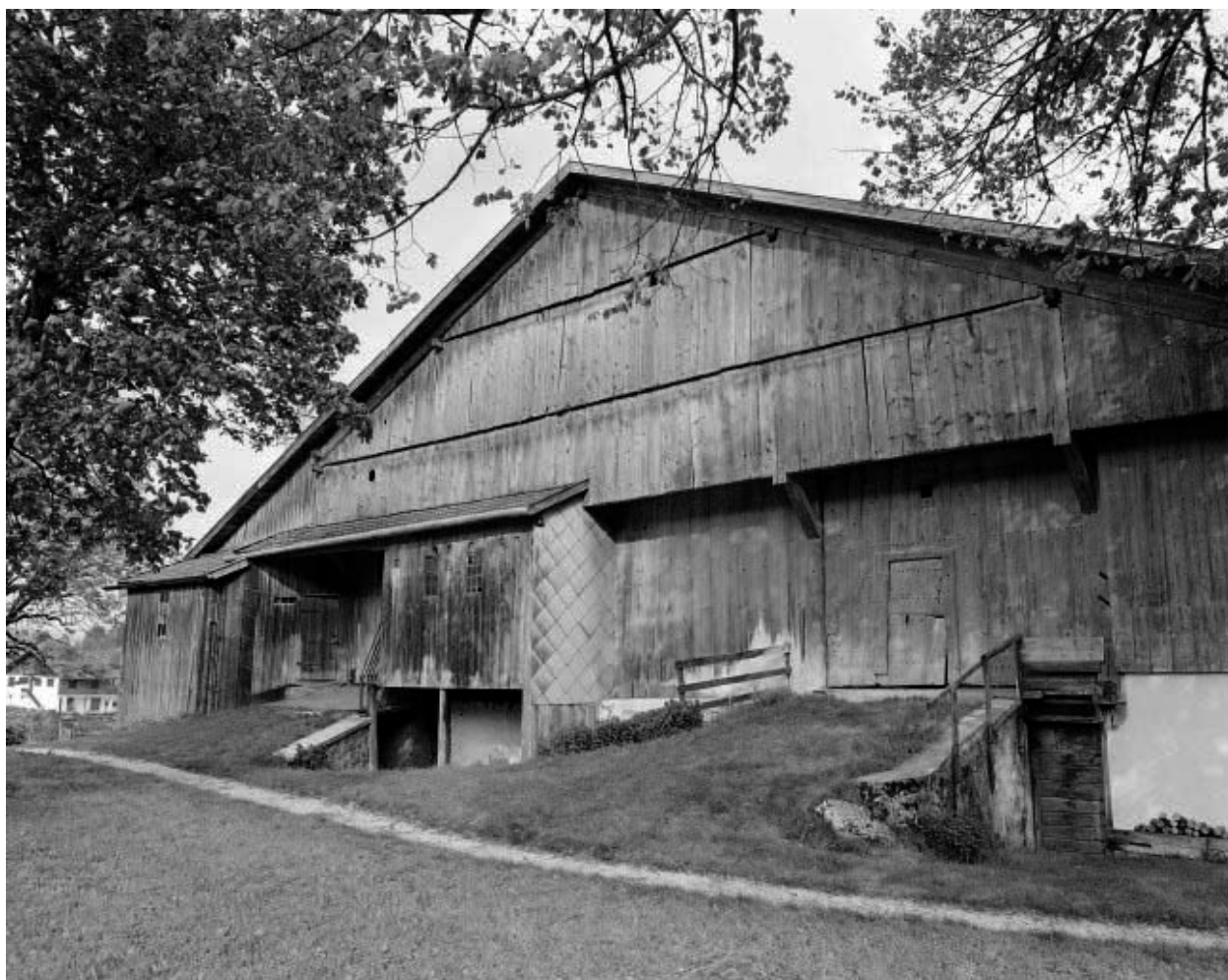
Façade postérieure en 1977, de trois quarts droite.
