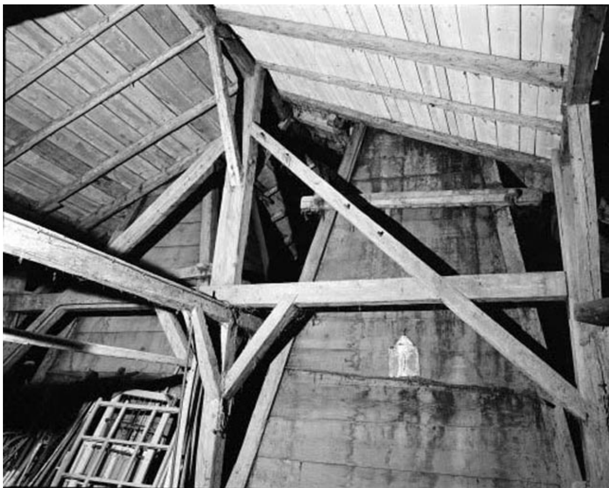
Intérieur en 1977, combles : ferme de charpente et hottes des "tués".
