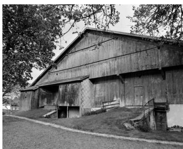
Façade postérieure en 1977, de trois quarts droite. Phot. Yves Sancey IVR43_19772500325X
