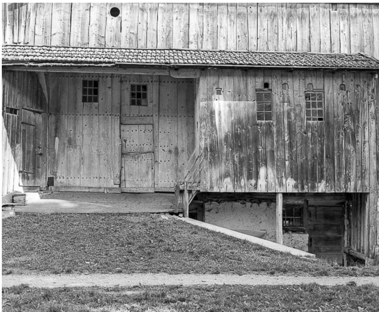
Façade postérieure en 1976 : détail.
