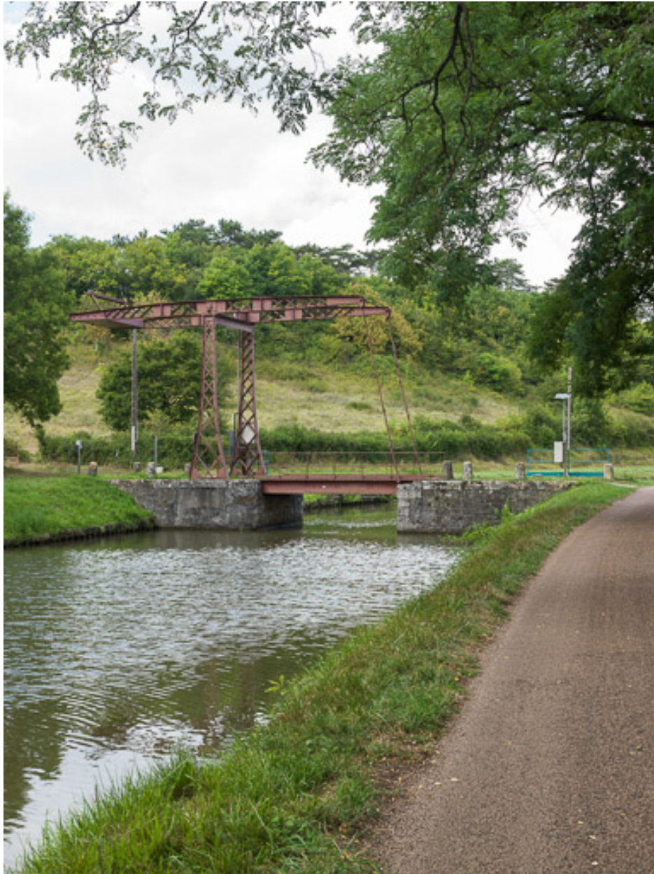
Vue d'ensemble du pont.
