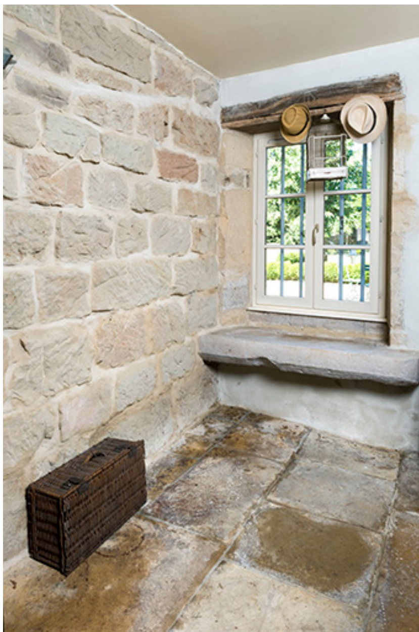
Pierre d'évier sous une baie et détail de mur intérieur au rez-de-chaussée de l'habitation.
