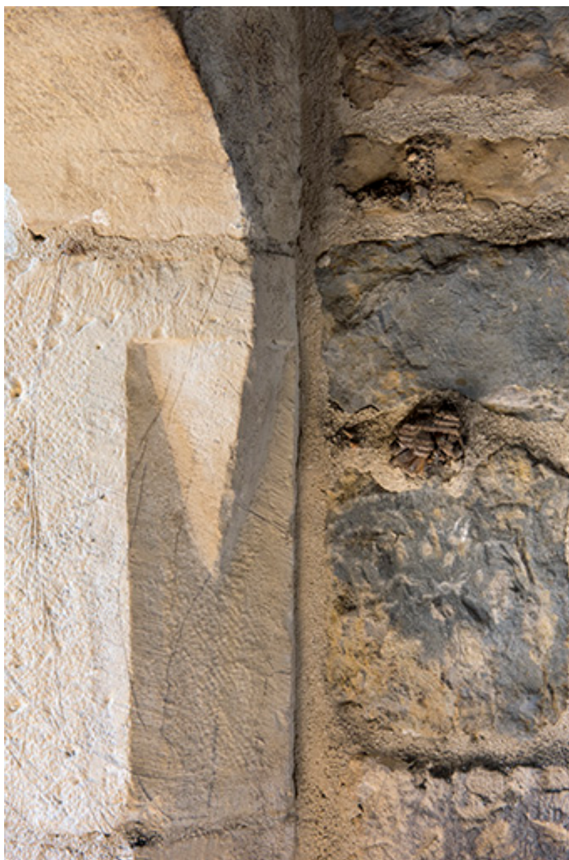
Détail sculpté des piédroits de la cheminée.
