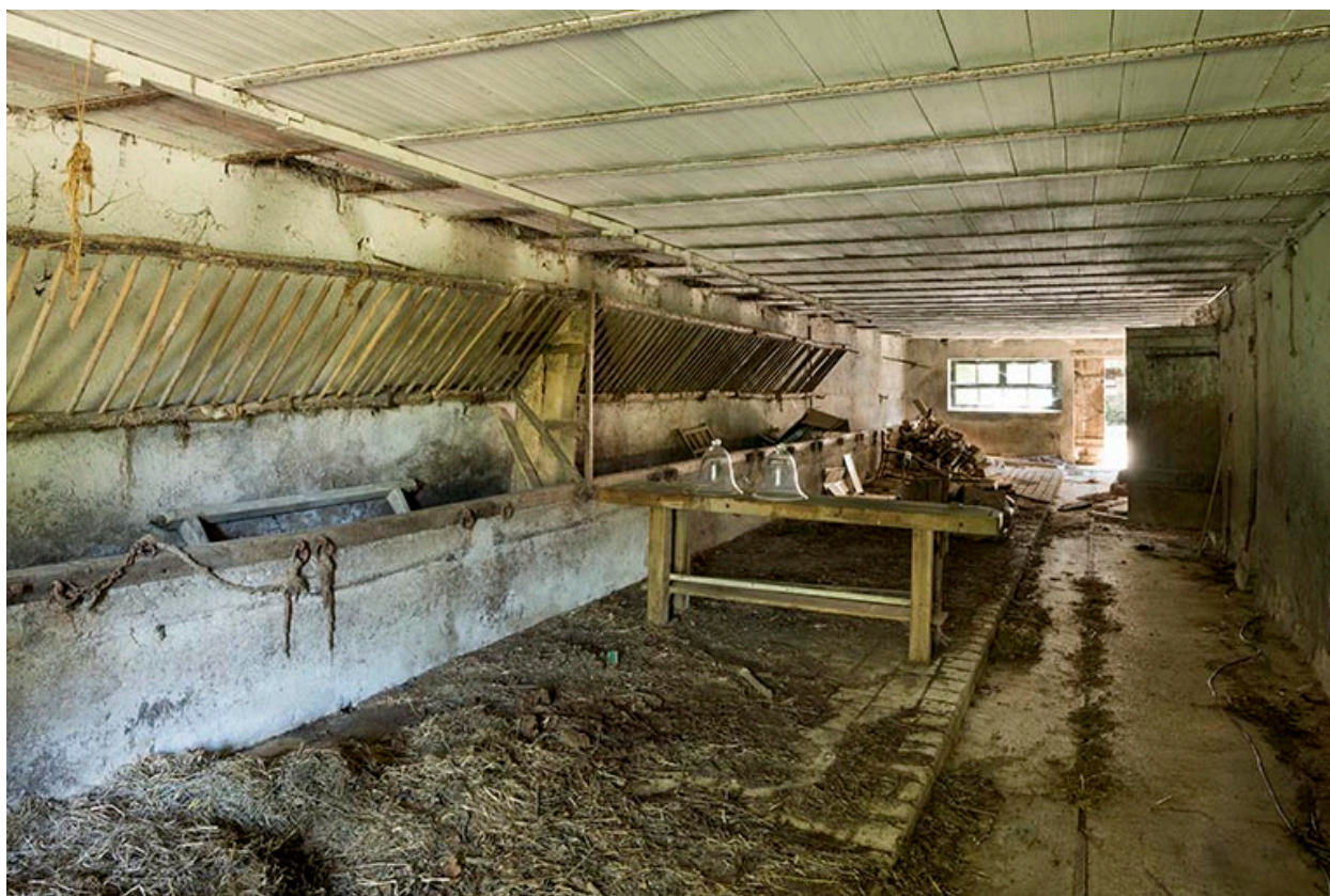
Vue intérieure de l'écurie.
