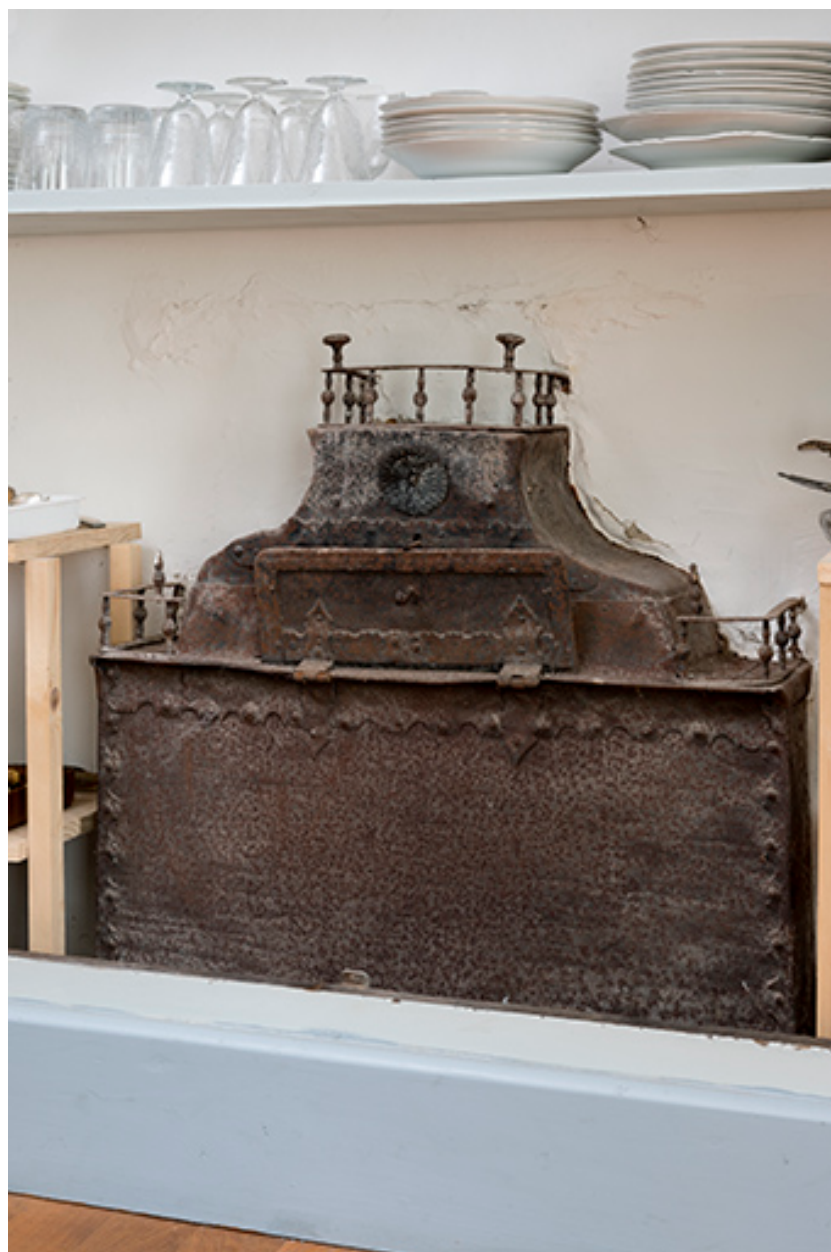
poêle-récupérateur de chaleur dans le placard chauffant de la salle à manger. Vue rapprochée.
