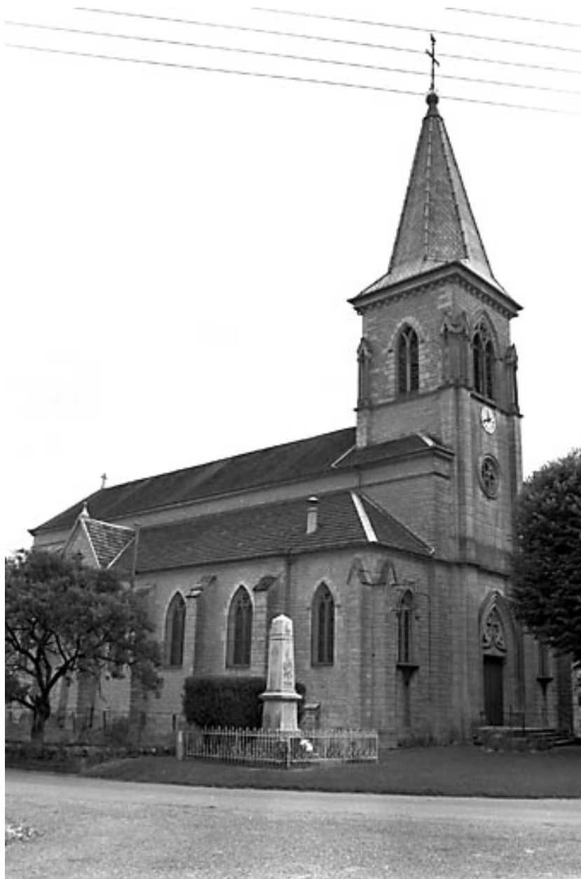
Façades antérieure et latérale gauche.
