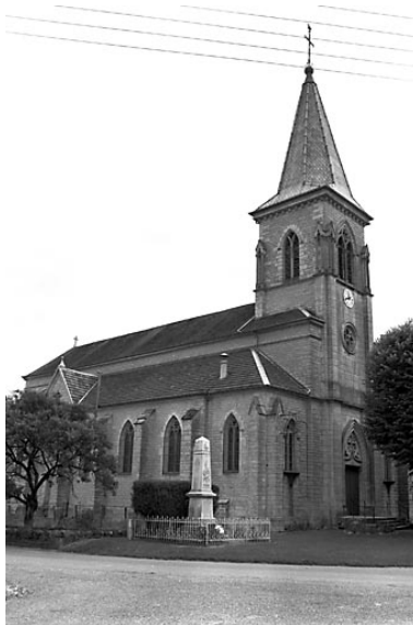
Façades antérieure et latérale gauche.
