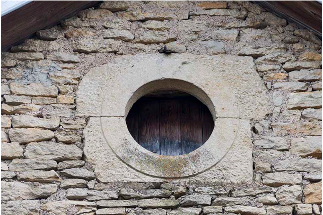
L'oculus, sur le pignon de la maison.
