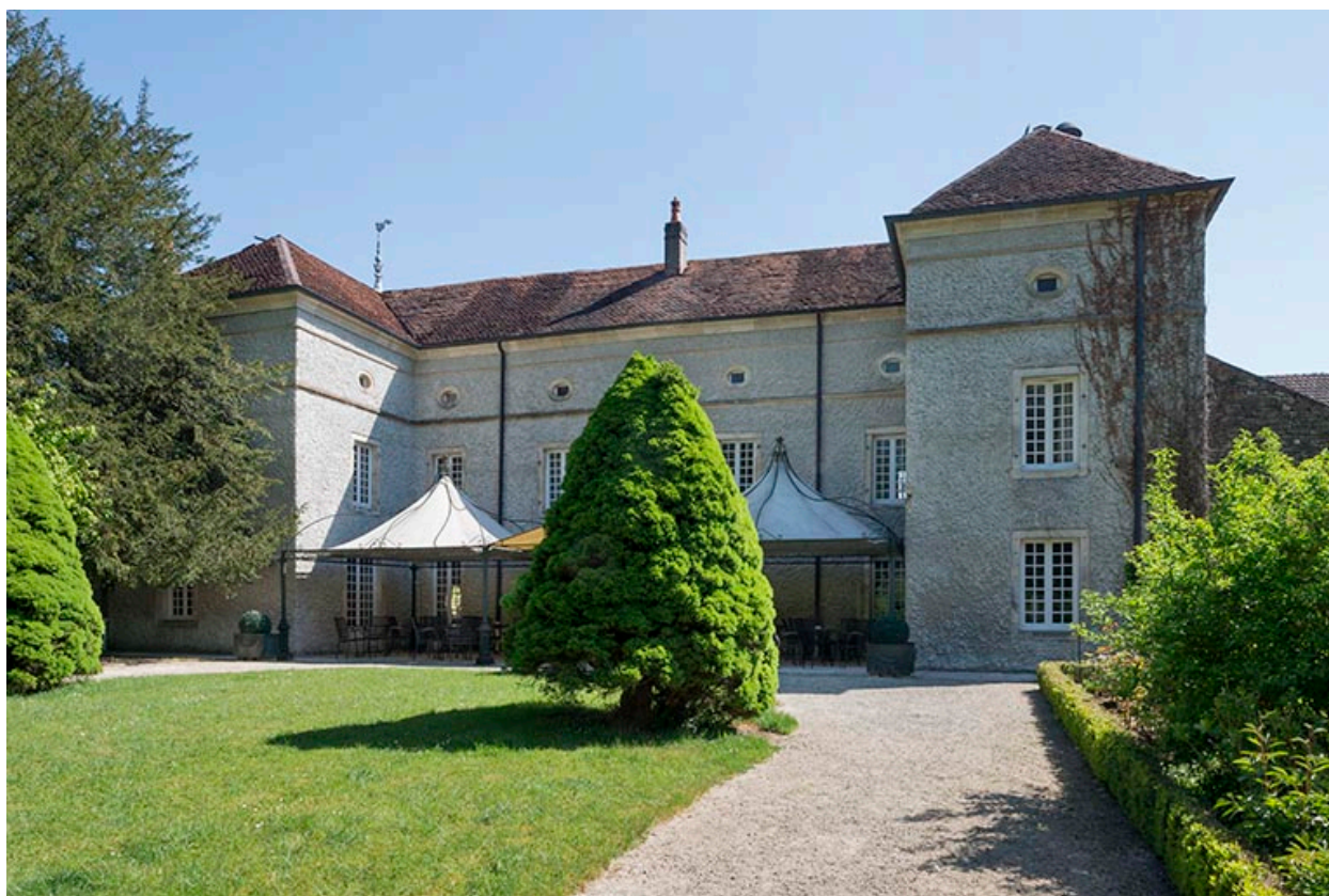
Vue générale, façade postérieure.
