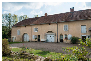
Vue générale. Phot. Jérôme Mongreville IVR43_20167001623NUC4A
