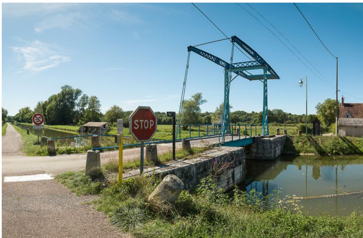
Vue d'ensemble du pont.
