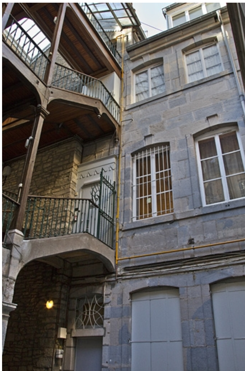
Façade postérieure du logis principal : vue d'ensemble.
