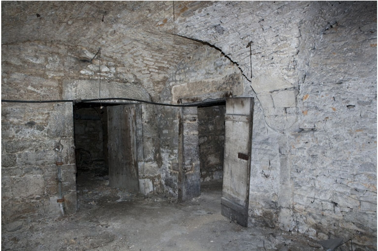
Logis principal, sous-sol : cave C.
