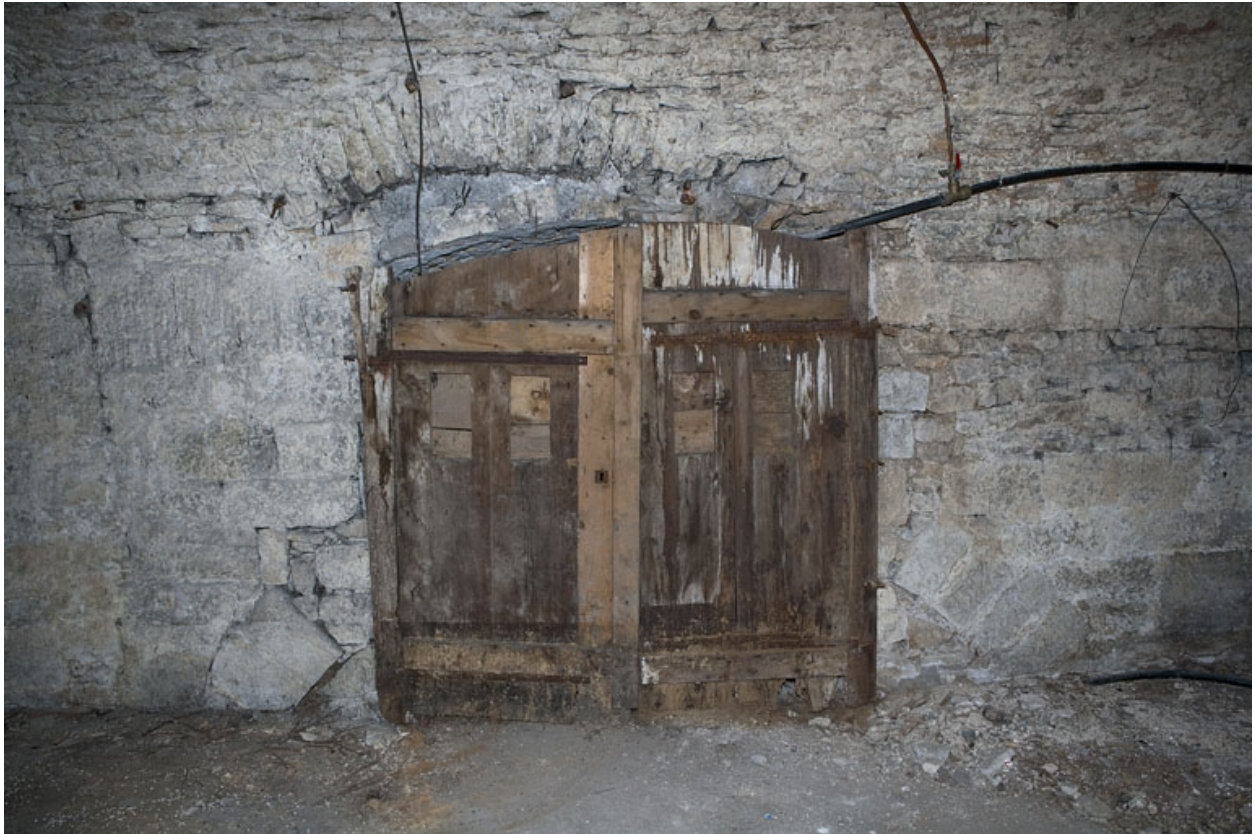
Logis principal, sous-sol : cave C.
