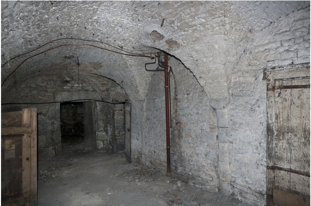
Logis principal, sous-sol : cave C.
