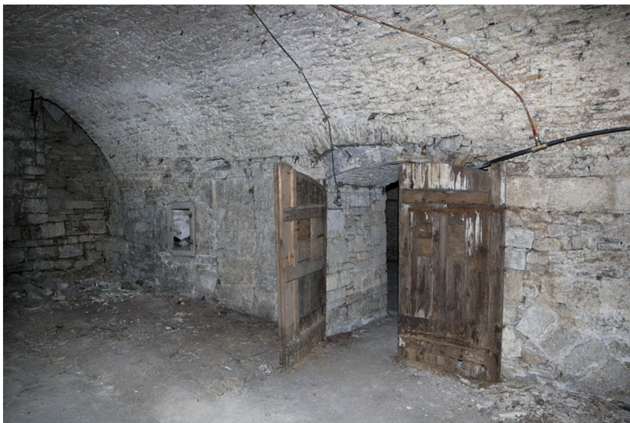
Logis principal, sous-sol : cave C.
