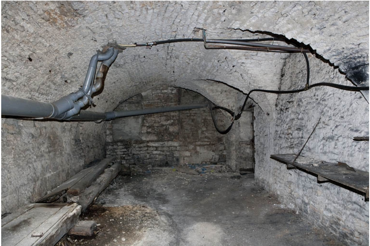
Logis principal, sous-sol : cave C, partie gauche.
