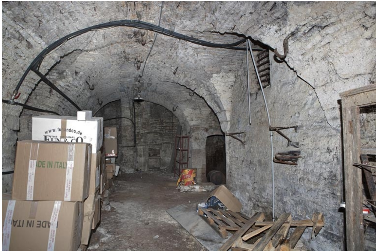
Logis principal, sous-sol : cave A depuis l'entrée.
