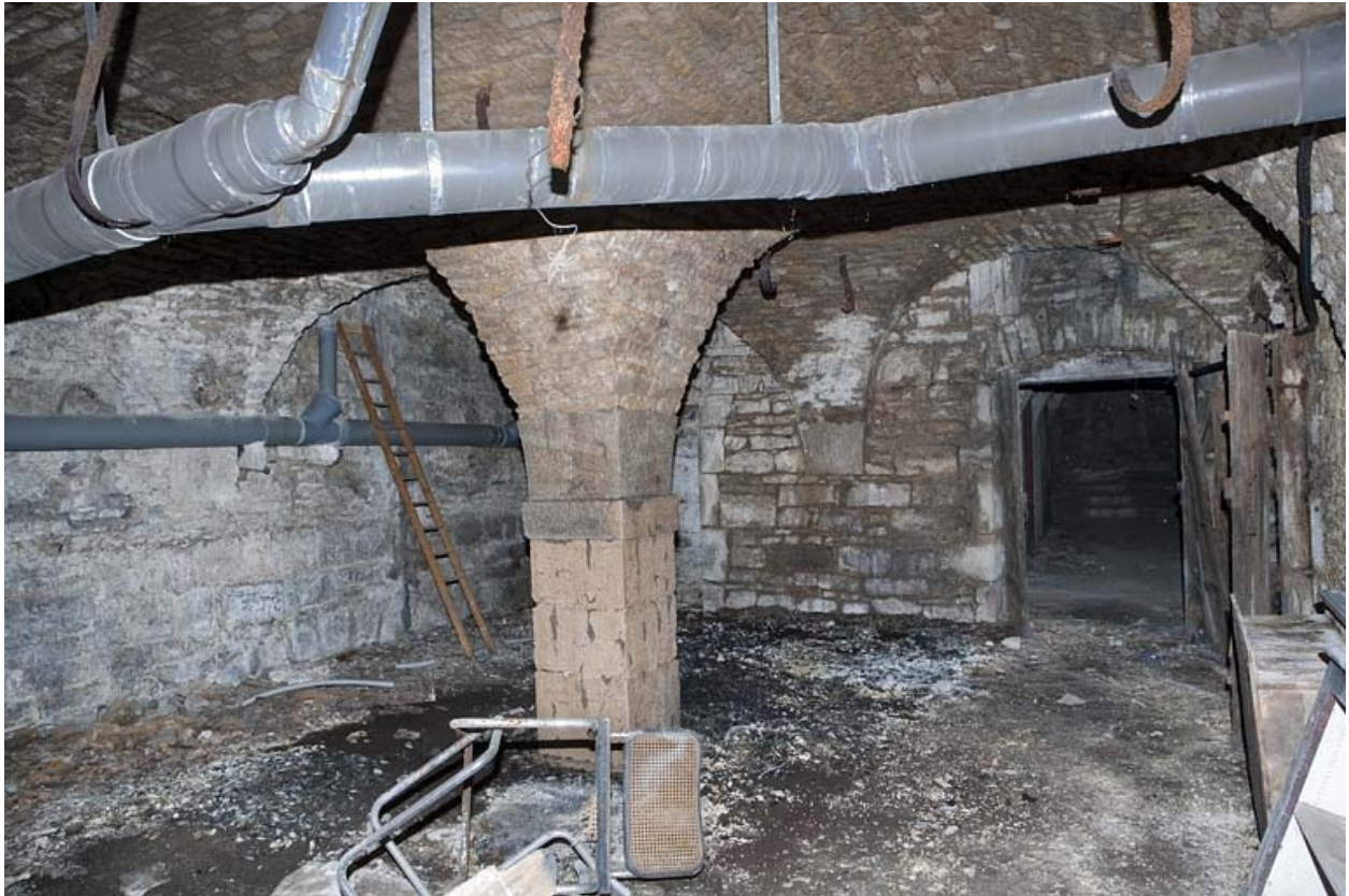
Logis principal, sous-sol : cave B, vue d'ensemble.
