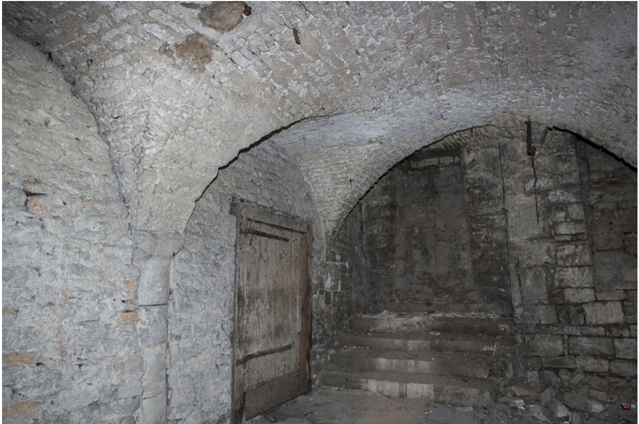
Logis principal, sous-sol : cave C.
