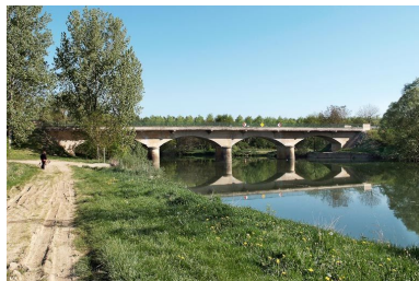
Pont vu d'amont. Phot. Jean-Luc Duthu IVR26_20107100549NUC2A
