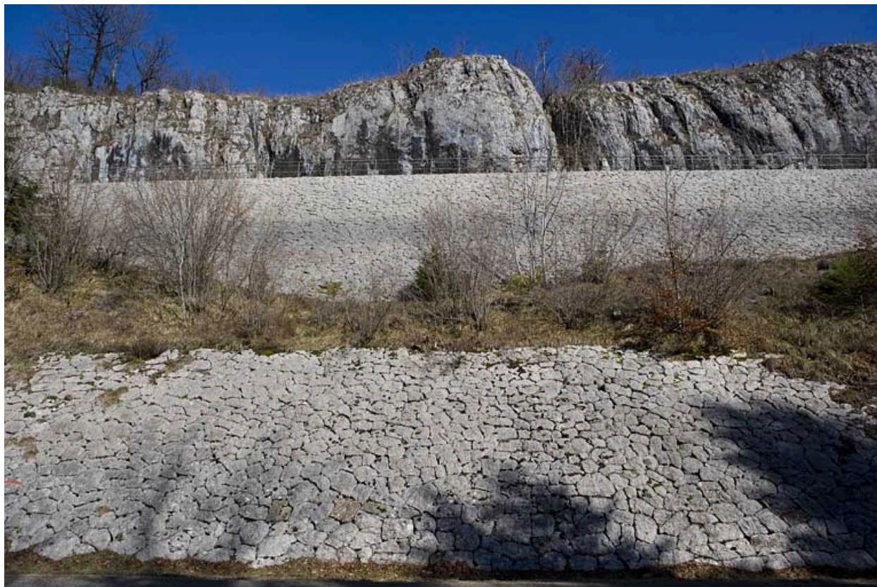
Murs de soutènement (commune de Champagnole), à droite de la voie avant le viaduc de Syam, vus de face. Mur situé entre les PK 017.000 et 018.000, en contre-haut de la R.D. 127.
