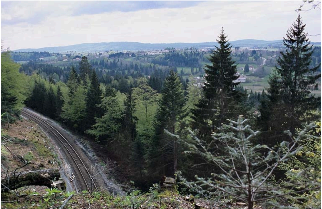
La voie vue du dessus du tunnel de la Joux (commune de Saint-Laurent-en-Grandvaux), côté Andelot-en-Montagne.
