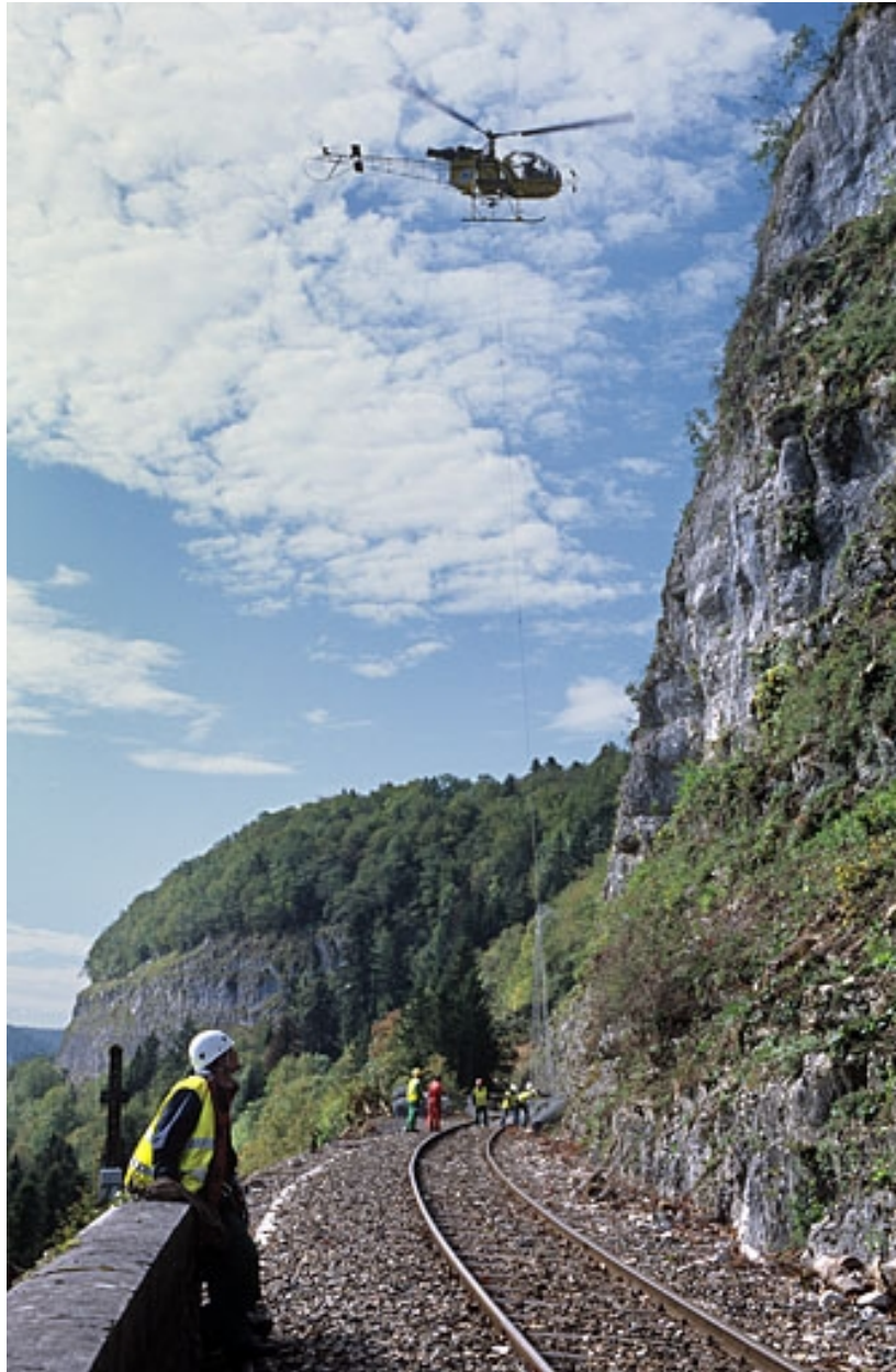
Sécurisation de paroi rocheuse à Syam : hélicoptère et rouleau de filet de protection en cours de levage.
