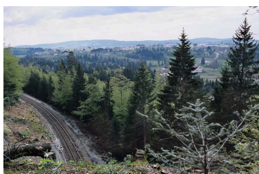
La voie vue du dessus du tunnel de la Joux (commune de Saint-Laurent-en-Grandvaux), côté Andelot-en-Montagne.
