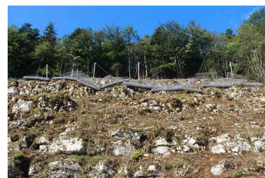
Sécurisation de paroi rocheuse à Syam : rouleaux de filet de protection en attente de déroulage. Phot. Yves Sancey IVR43_20043900547ZA
