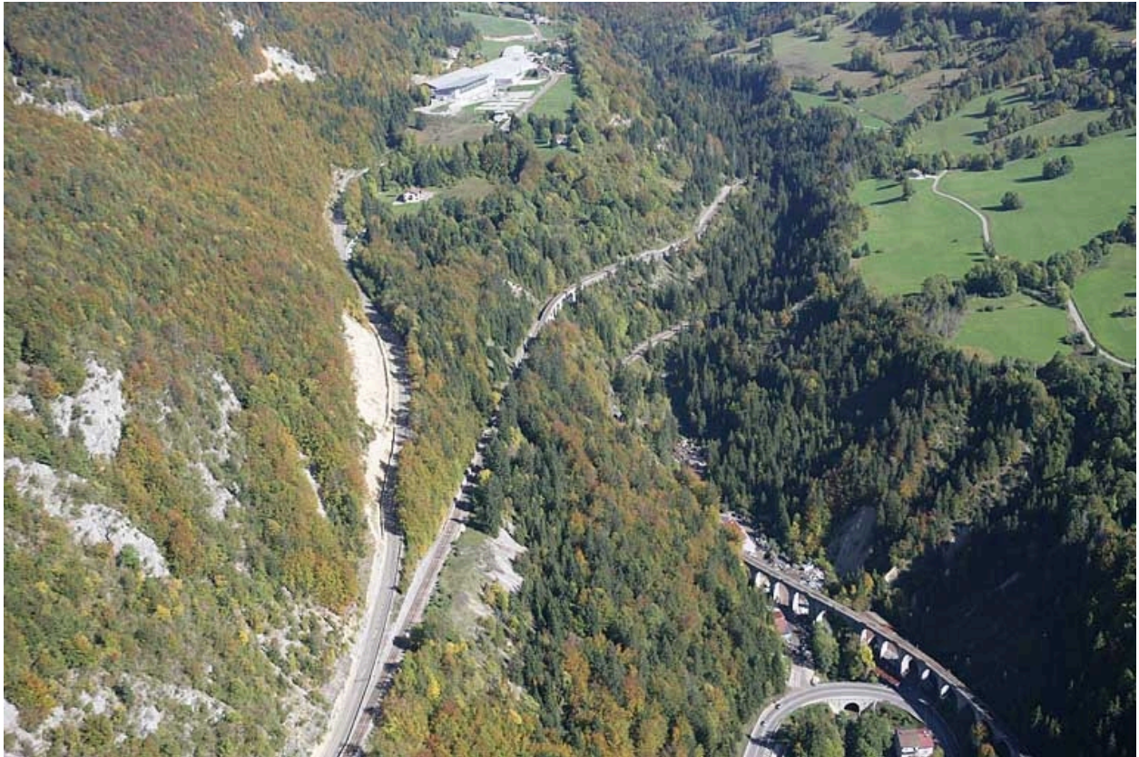
Vue aérienne des ouvrages situés entre les viaducs des Crottes et de la Source, depuis le sud-ouest.
