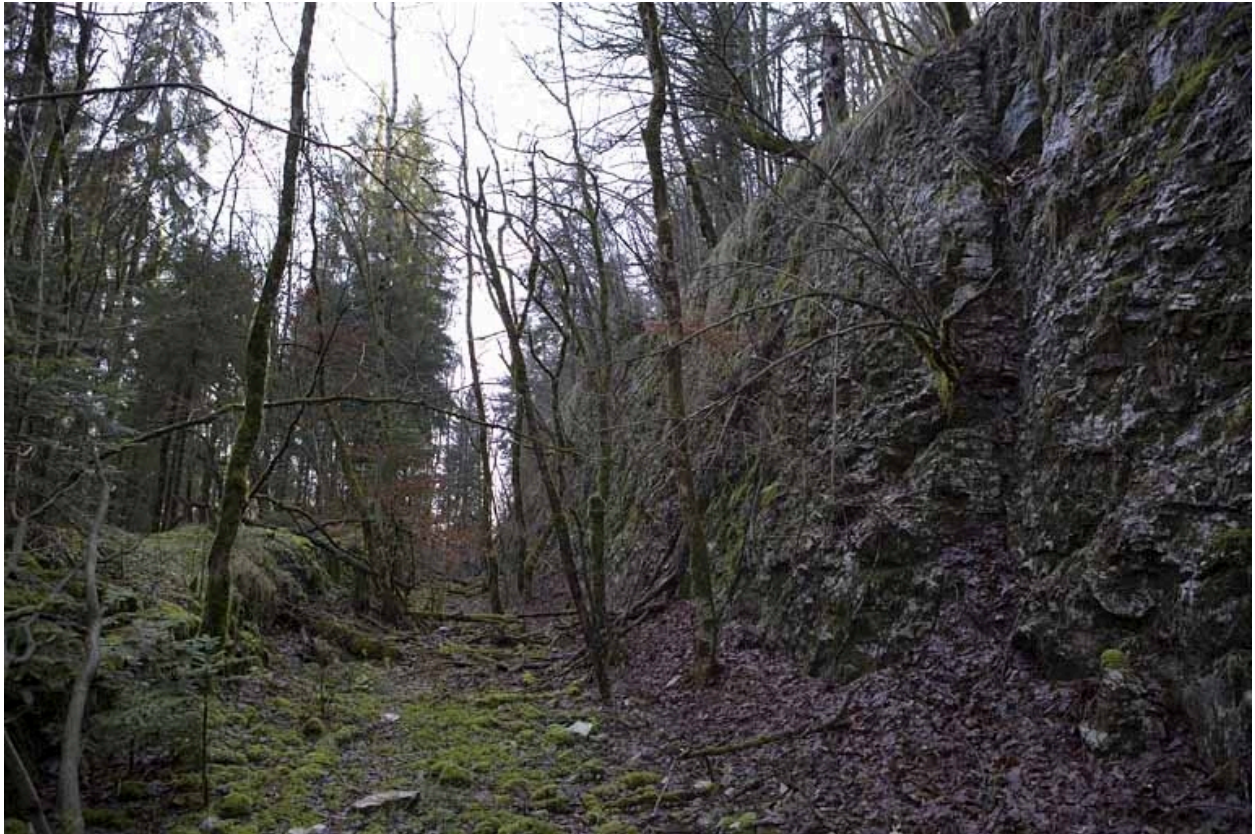
Tranchée du premier tracé abandonnée, rive gauche de l'Ain, à proximité du viaduc de Syam (commune de Cize).
