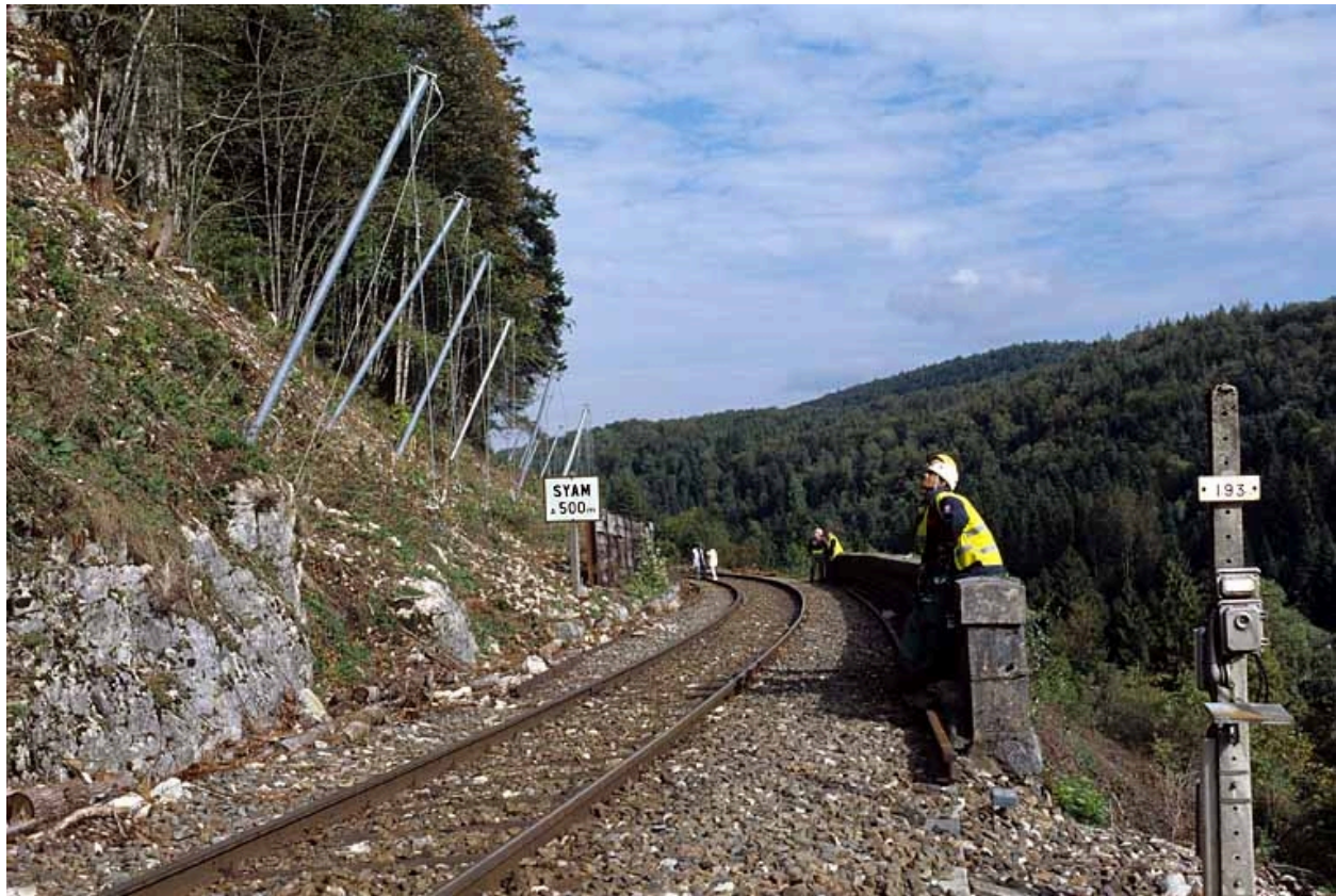
Sécurisation de paroi rocheuse à Syam : système d'ancrage des filets de protection près de la voie.
