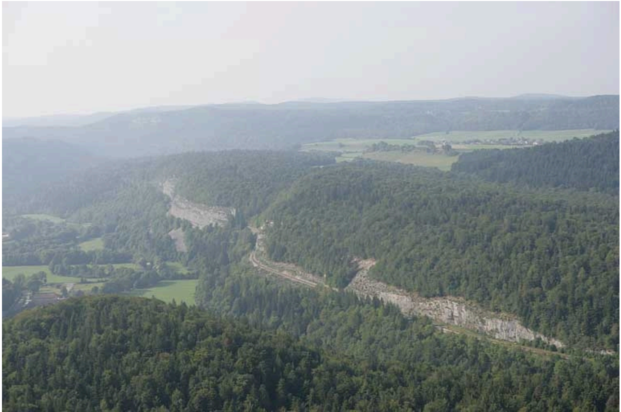
Vue aérienne de la voie à l'emplacement de la gare de Syam, depuis le nord-est.
