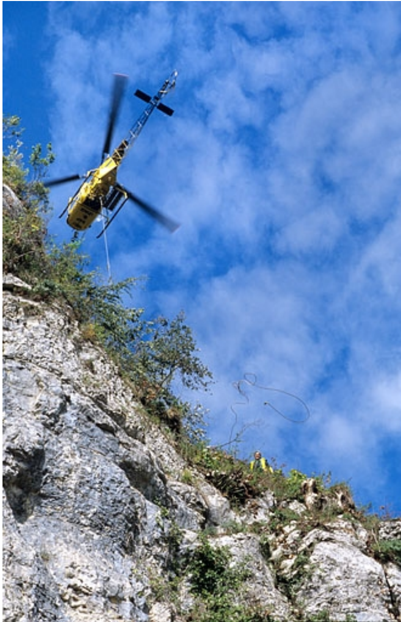
Sécurisation de paroi rocheuse à Syam : hélicoptère et ouvrier, depuis la voie.
