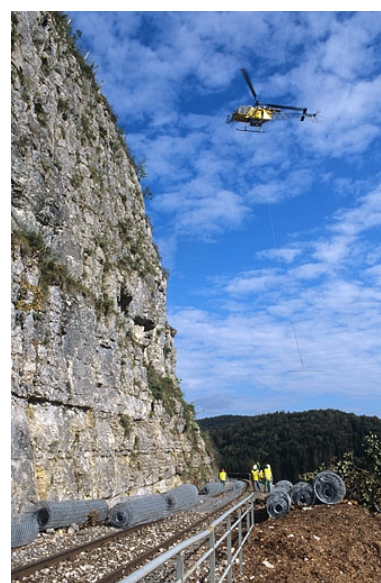
Sécurisation de paroi rocheuse à Syam : hélicoptère venant chercher un rouleau de filet de protection. Phot. Yves Sancey IVR43_20043900552ZA
