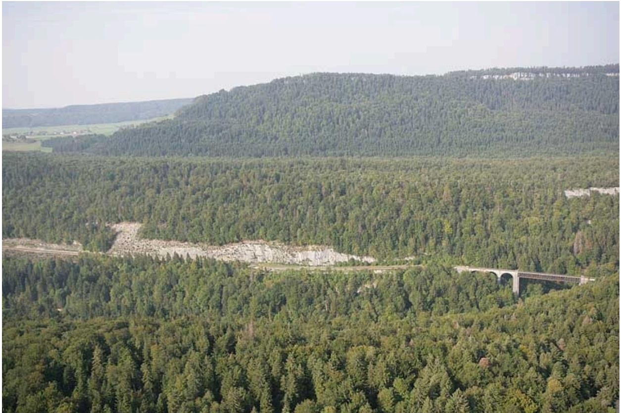
Vue aérienne de la voie et du viaduc de Syam, depuis l'est. Au centre, emplacement de la gare de Syam.
