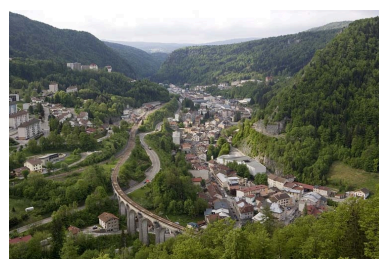
Vue d'ensemble de la voie et de la ville de Morez, depuis le viaduc des Crottes.
