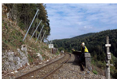
Sécurisation de paroi rocheuse à Syam : système d'ancrage des filets de protection près de la voie. Phot. Yves Sancey IVR43_20043900548ZA
