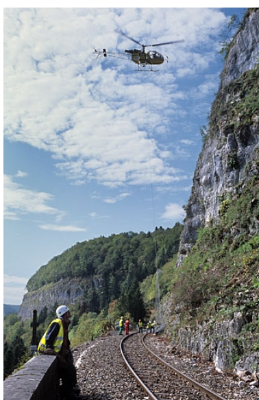
Sécurisation de paroi rocheuse à Syam : hélicoptère et rouleau de filet de protection en cours de levage. Phot. Yves Sancey IVR43_20043900550ZA
