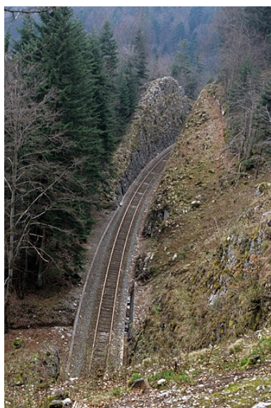
Tranchée à la sortie du tunnel de Malproche (commune du Vaudioux), côté La Cluse.
