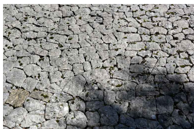
Mur de soutènement (commune de Champagnole), à droite de la voie avant le viaduc de Syam : détail de l'appareil. Mur situé entre les PK 017.000 et 018.000, en contre-haut de la R.D. 127.
