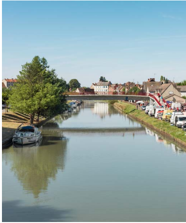
Vue d'ensemble de la passerelle. Phot. Pierre-Marie Barbe-Richaud IVR26_20177100233NUC2A
