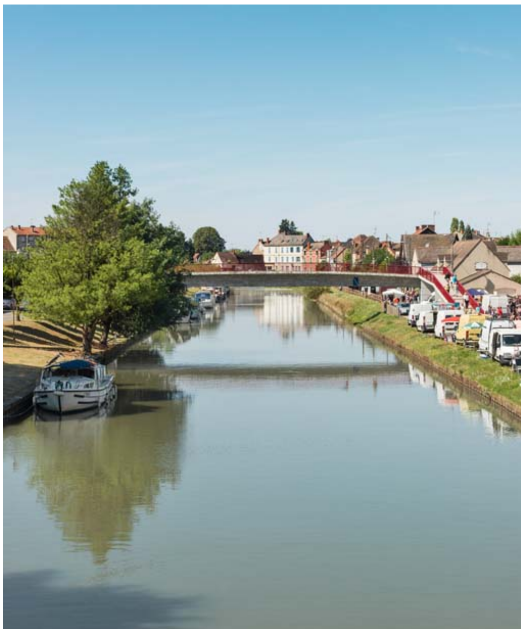
Vue d'ensemble de la passerelle.
