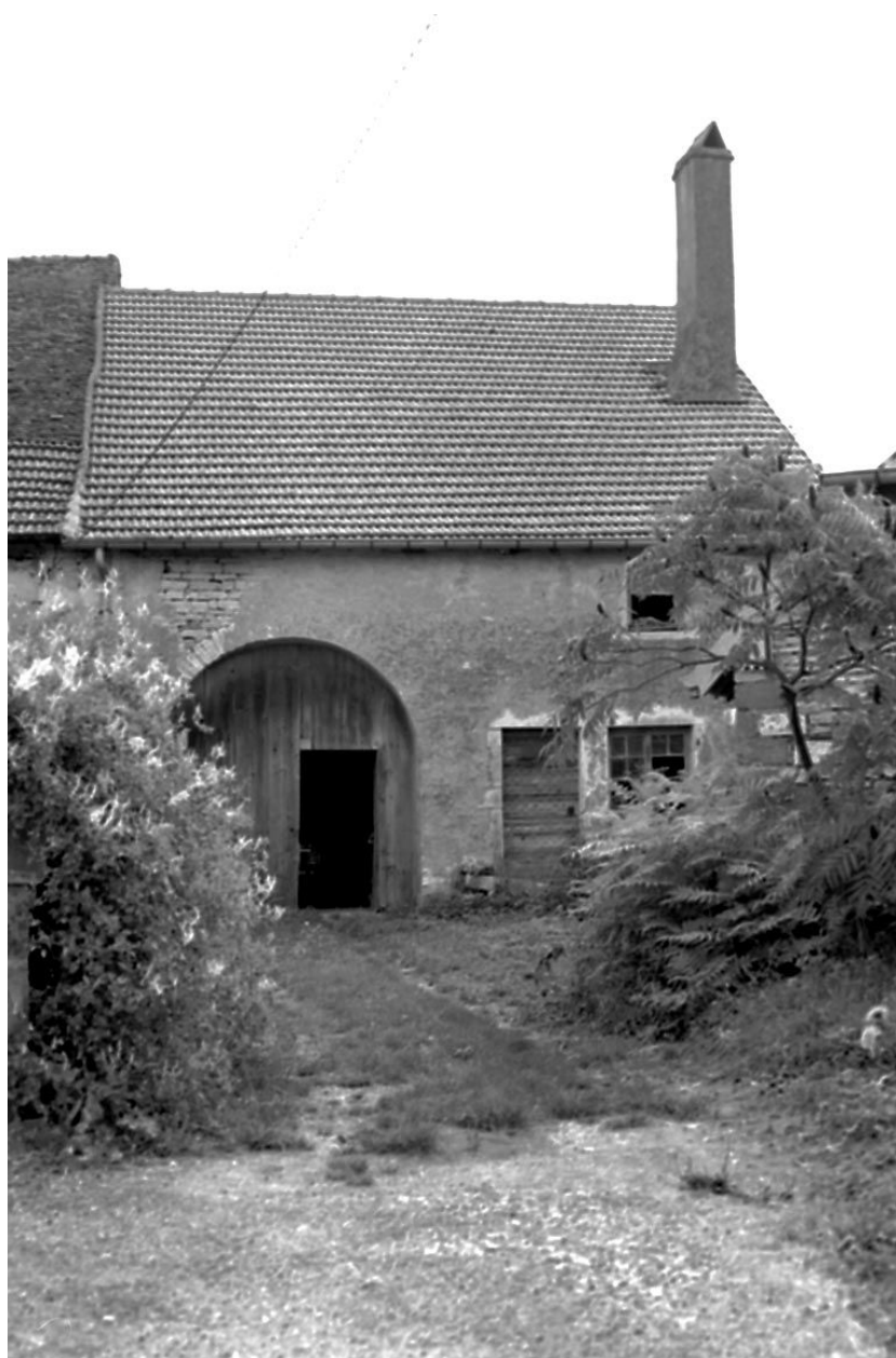
Ferme située place de la Bascule (détruite entre 1987 et 2019).
