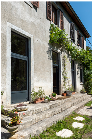
Façade antérieure et perron, vus en enfilade. Phot. Sonia Dourlot IVR43_20192501466NUC4A
