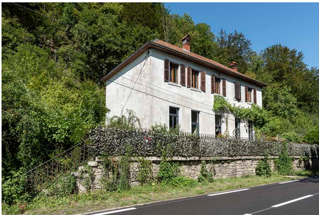
Façades antérieure et latérale gauche.
