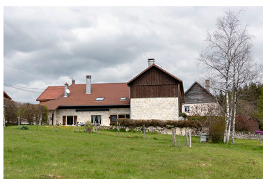
Façade latérale droite. Phot. Sonia Dourlot IVR43_20192500349NUC4A
