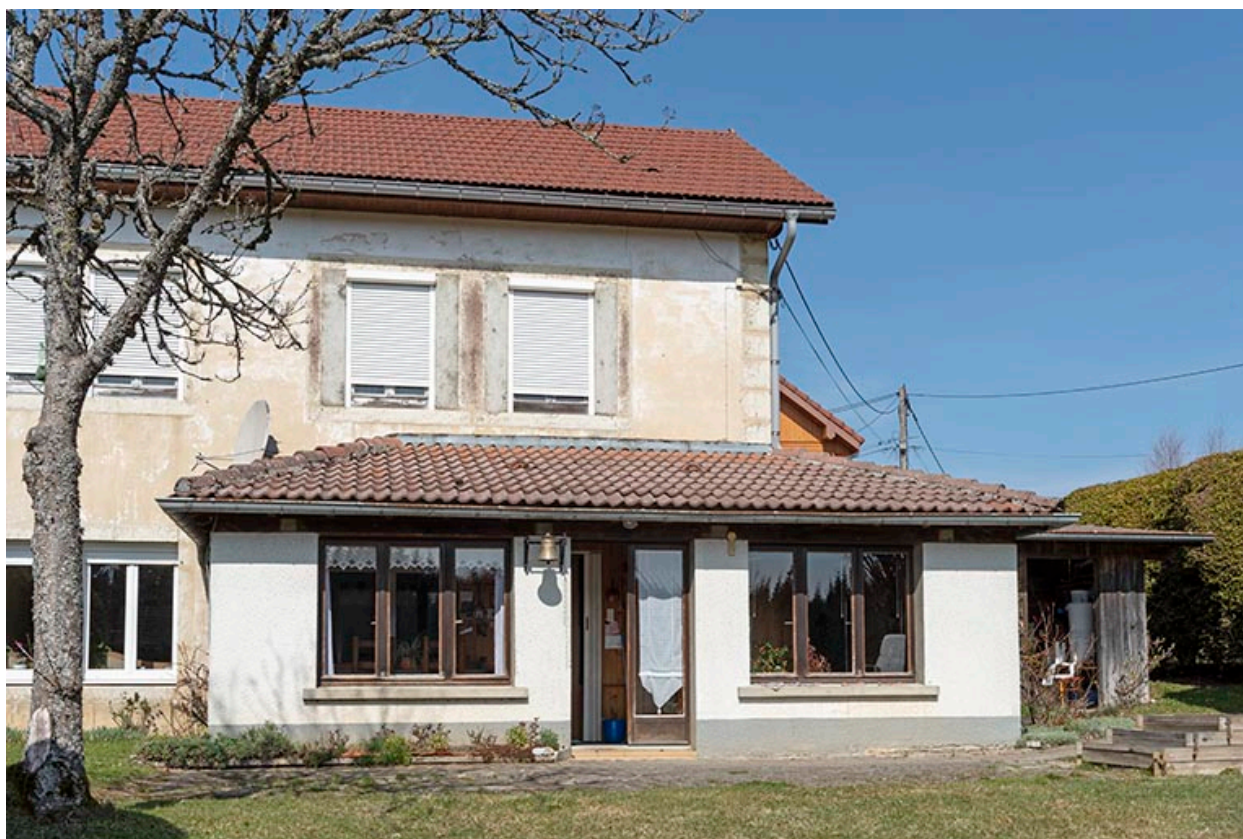
Façade postérieure : extension orientale.
