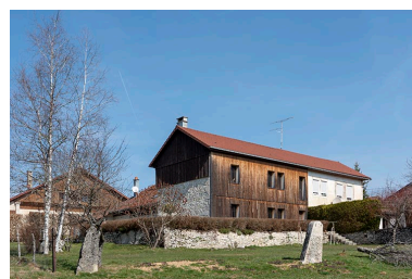
Façade postérieure, de trois quarts gauche. Phot. Sonia Dourlot IVR43_20192500350NUC4A
