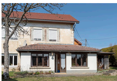
Façade postérieure : extension orientale. Phot. Sonia Dourlot IVR43_20192500352NUC4A
