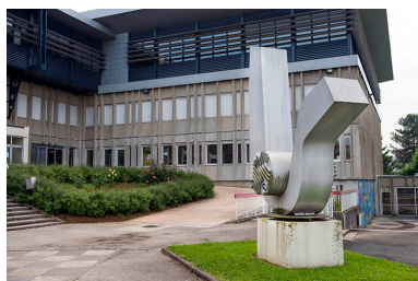
Vue sur les deux œuvres. Phot. Mary Ruffinoni IVR43_20132500724NUC4A
