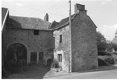
Ferme avec habitation débordante : façade antérieure. Phot. Bernard Lardière IVR43_19817000306Z
