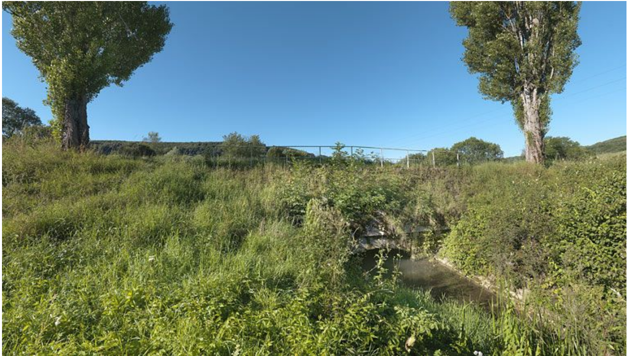
L'aqueduc du site d'écluse 16.
