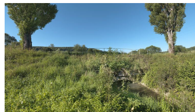
L'aqueduc du site d'écluse 16. Phot. Thierry Kuntz IVR26_20122102240NUC4AQ
