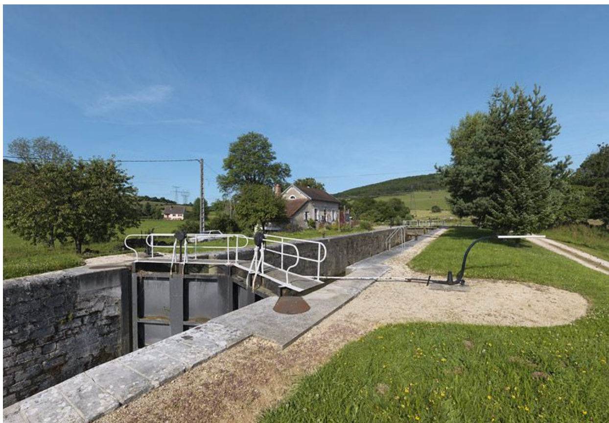
Vue aval du site d'écluse 16.
