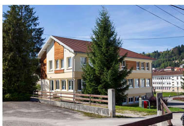
Façades postérieure et latérale gauche.
