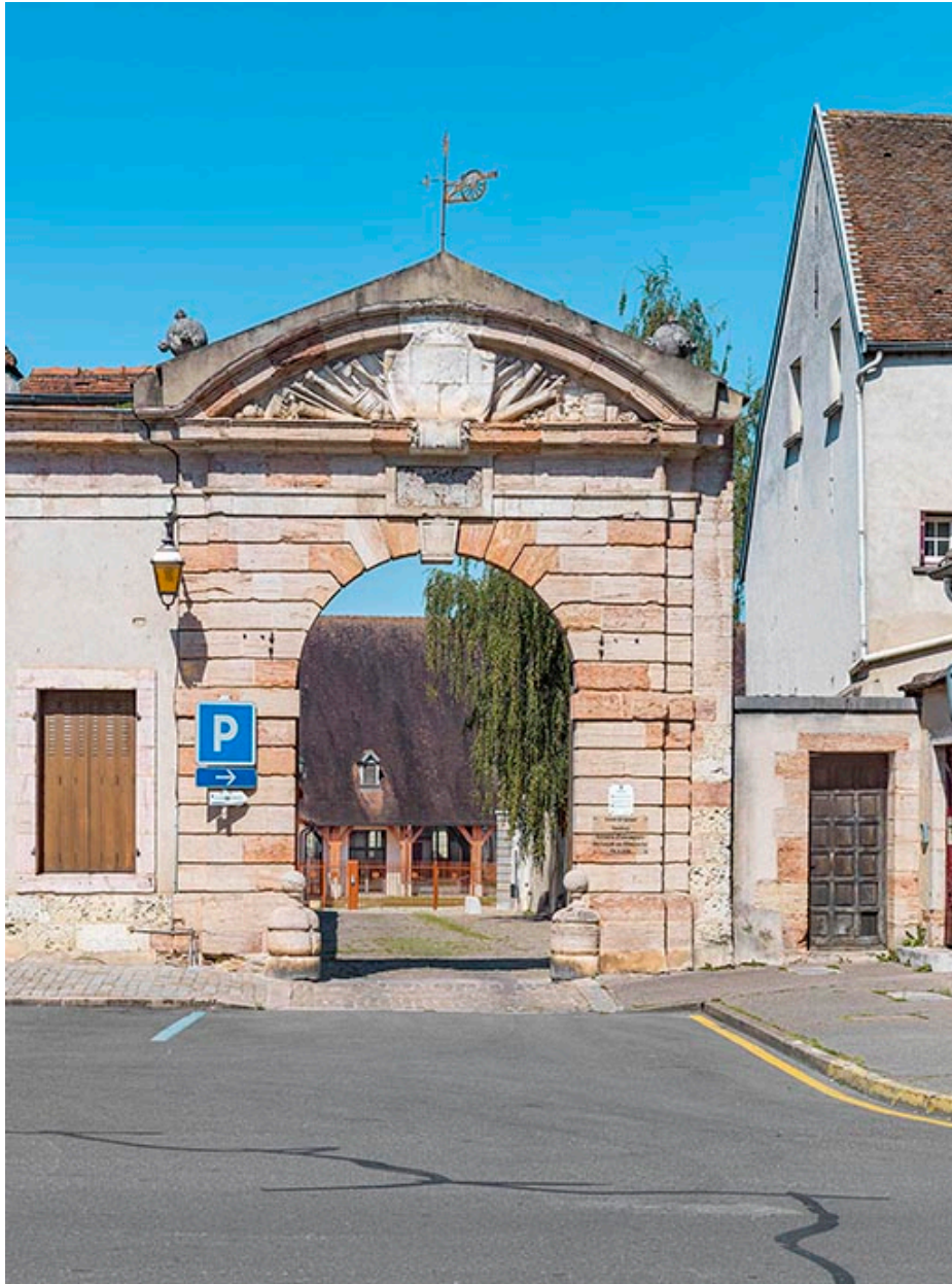
Portail ouvrant sur la rue du Capitaine Landolphe.
