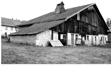
Façade antérieure. Phot. Dominique Humbert IVR43_19762500124X
