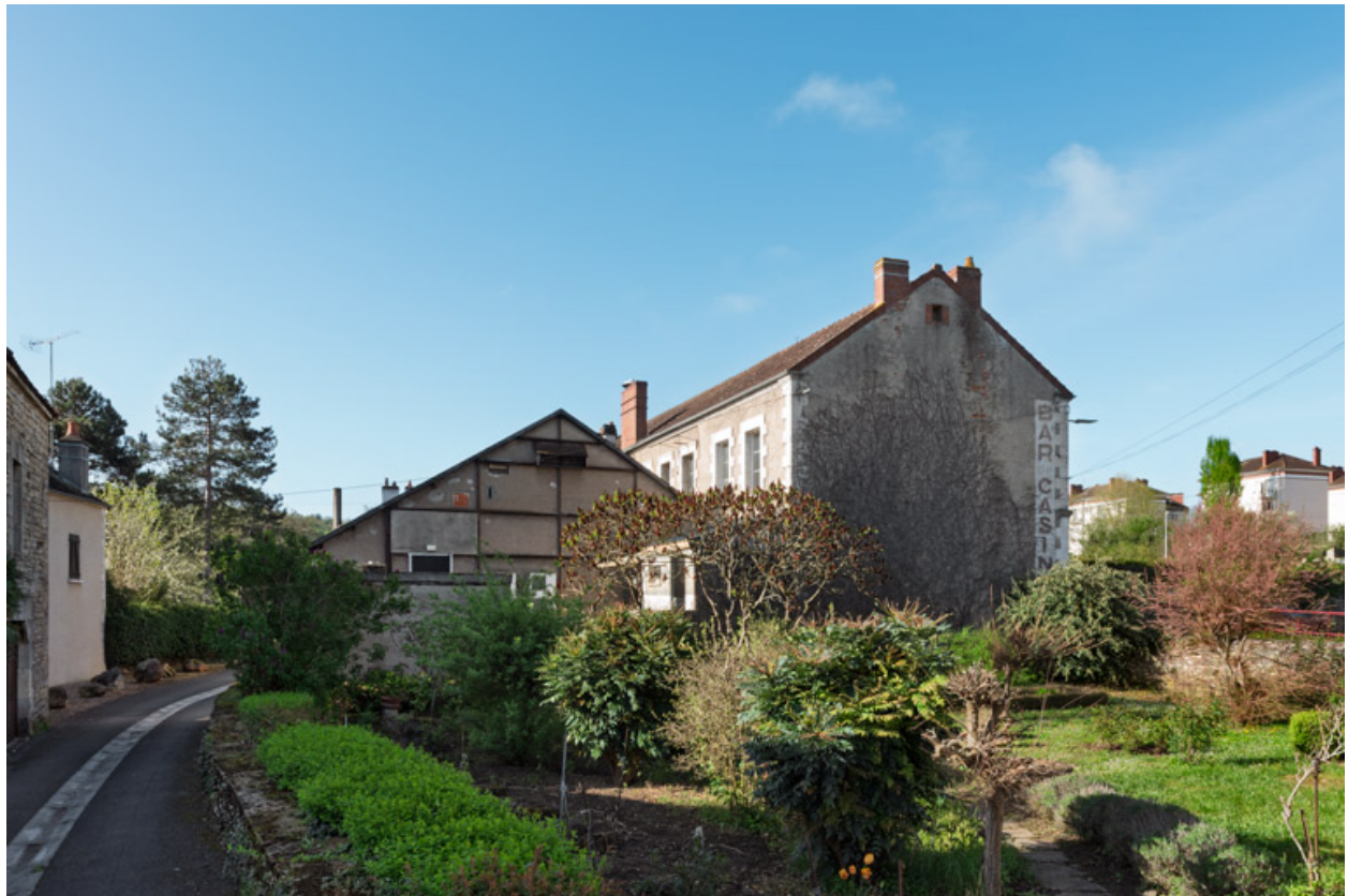
Façade postérieure et salle 1, depuis le nord-est.
