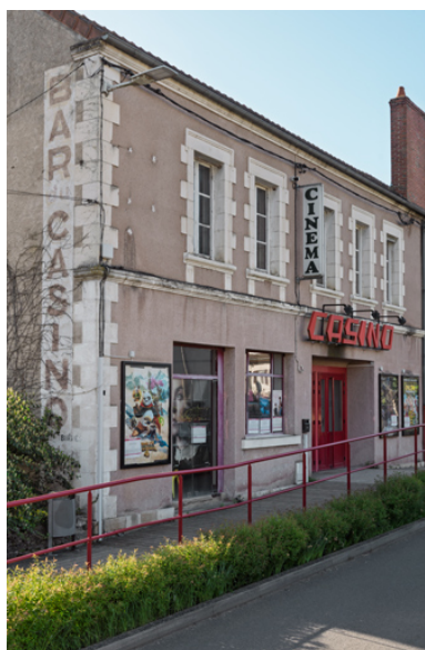
Entrée du cinéma, de trois quarts gauche. Phot. Pierre-Marie Barbe-Richaud IVR26_20245800225NUC4A
