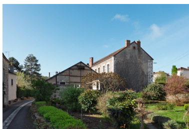
Façade postérieure et salle 1, depuis le nord-est. Phot. Pierre-Marie Barbe-Richaud IVR26_20245800227NUC4A
