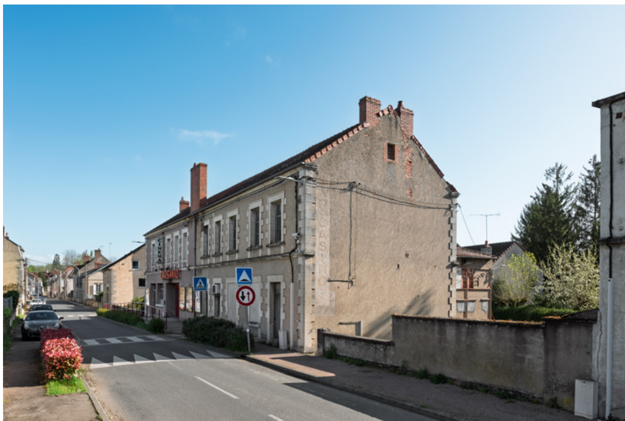
Vue d'ensemble, depuis le sud (façade antérieure).
