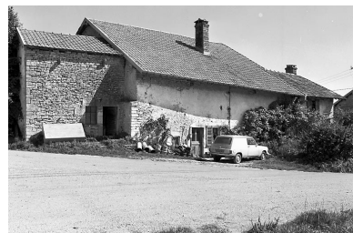
Ferme située 12 Grande Rue. Phot. Yves Sancey IVR43_19802500903X
