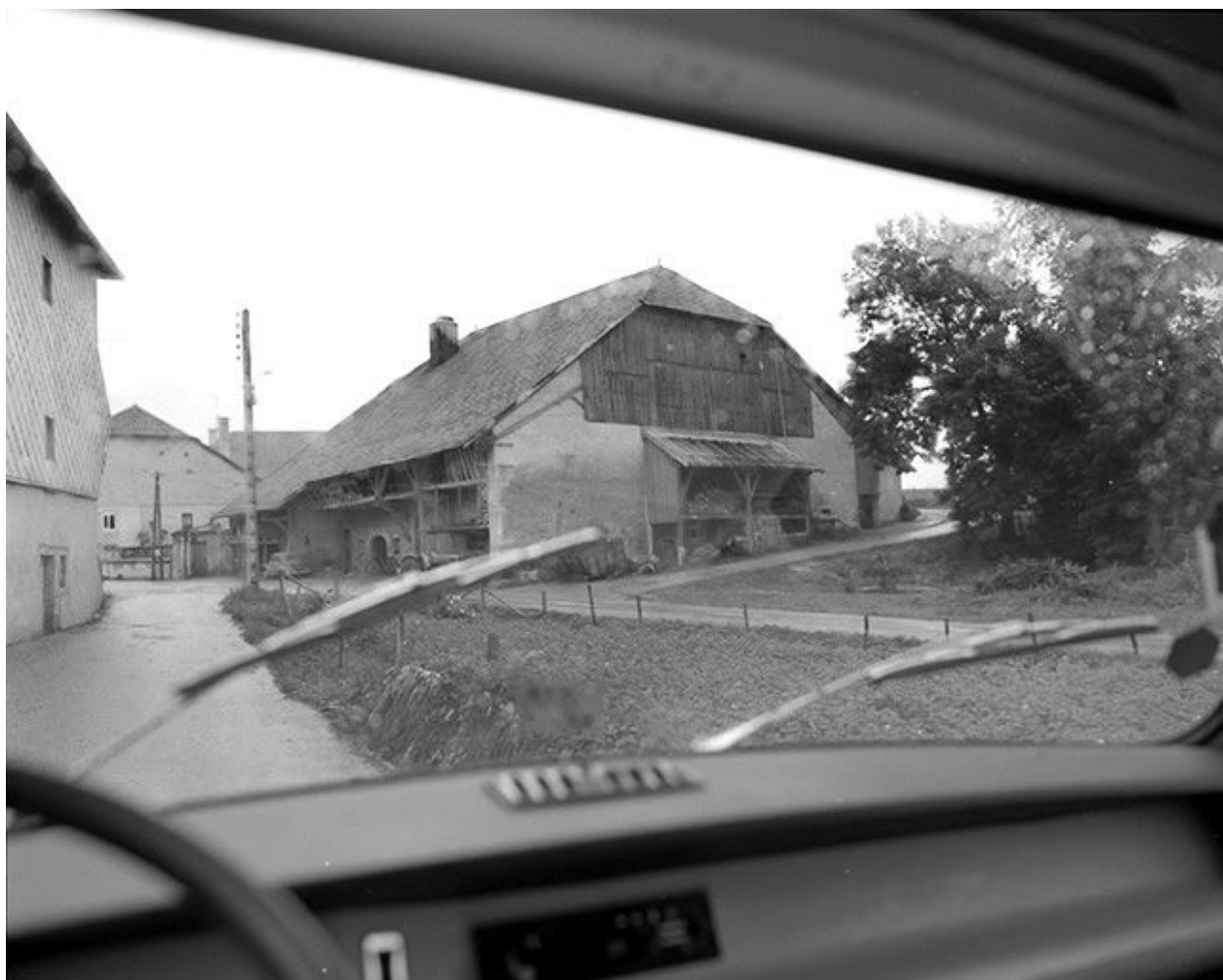
Façades postérieure et latérale droite.
