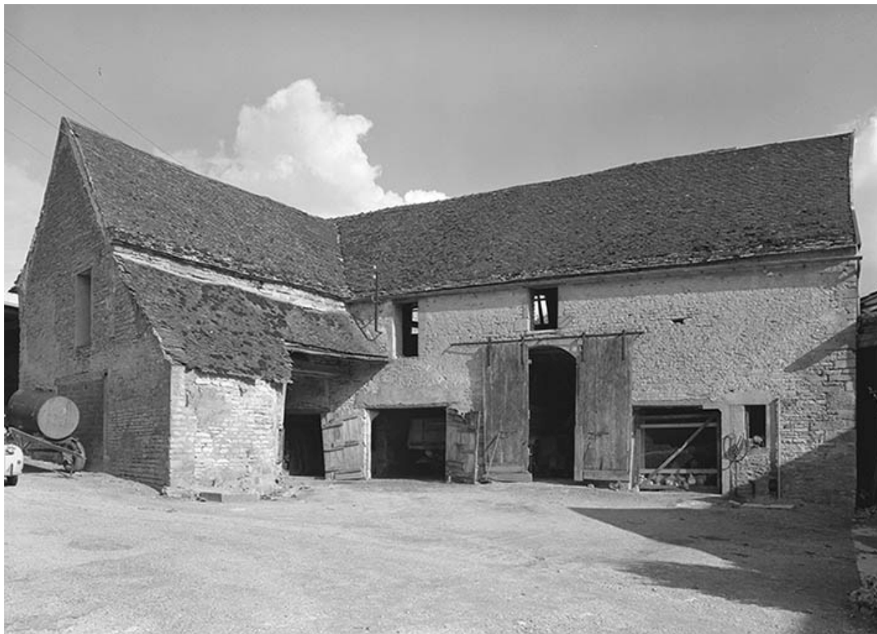
Bâtiments d'exploitation. Façades sur cour.
