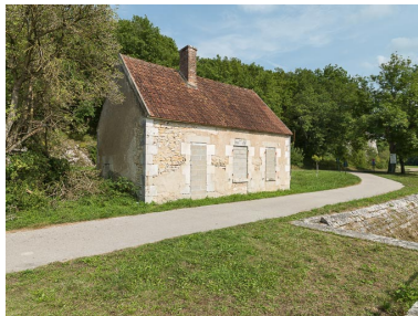
Vue de la maison éclusière.
