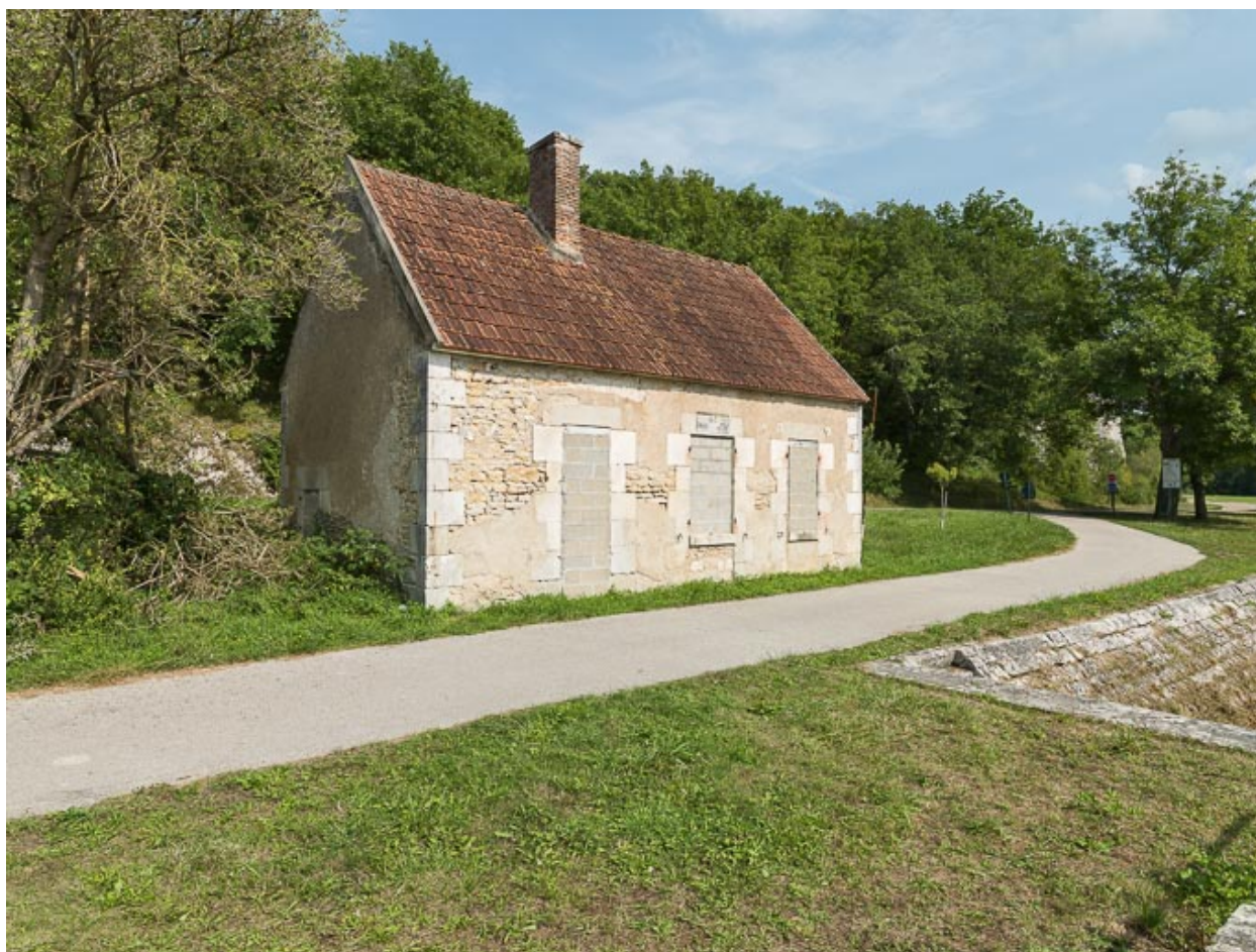
Vue de la maison éclusière.
