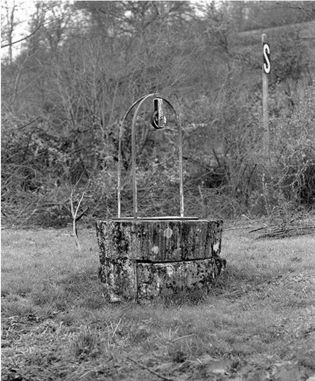
Détail du puits de maison d'éclusier.
