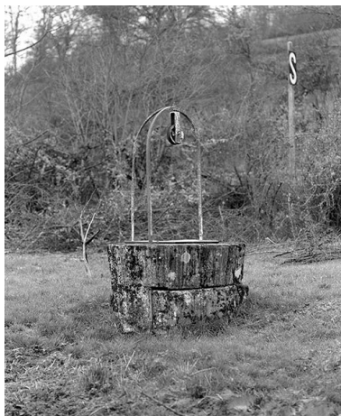
Détail du puits de maison d'éclusier. Phot. Jean-Luc Duthu IVR26_19925800263X
