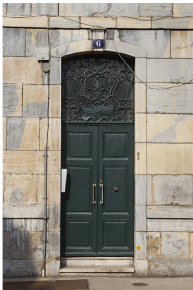
Façade antérieure : détail de la porte d'entrée. Phot. Yves Sancey IVR43_20112501816NUC2A
