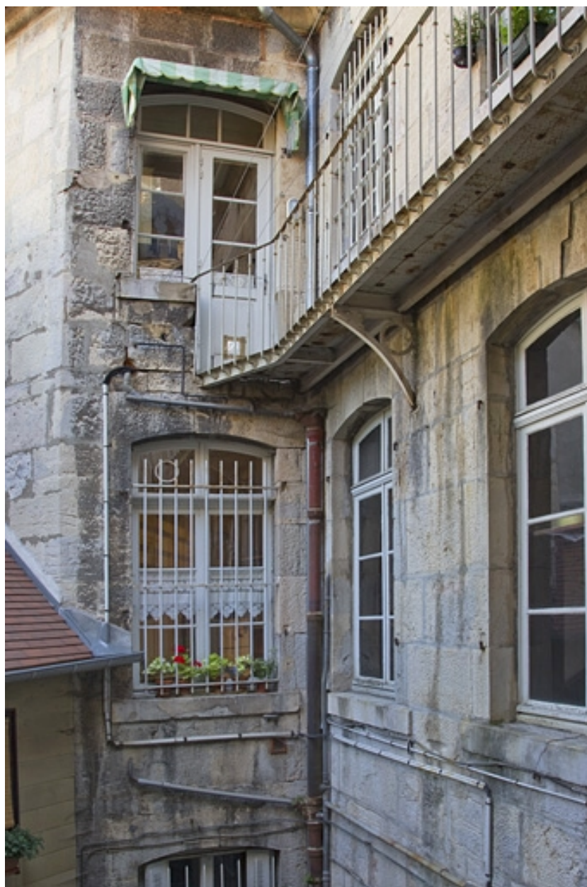
Logis : détail de la façade postérieure.
