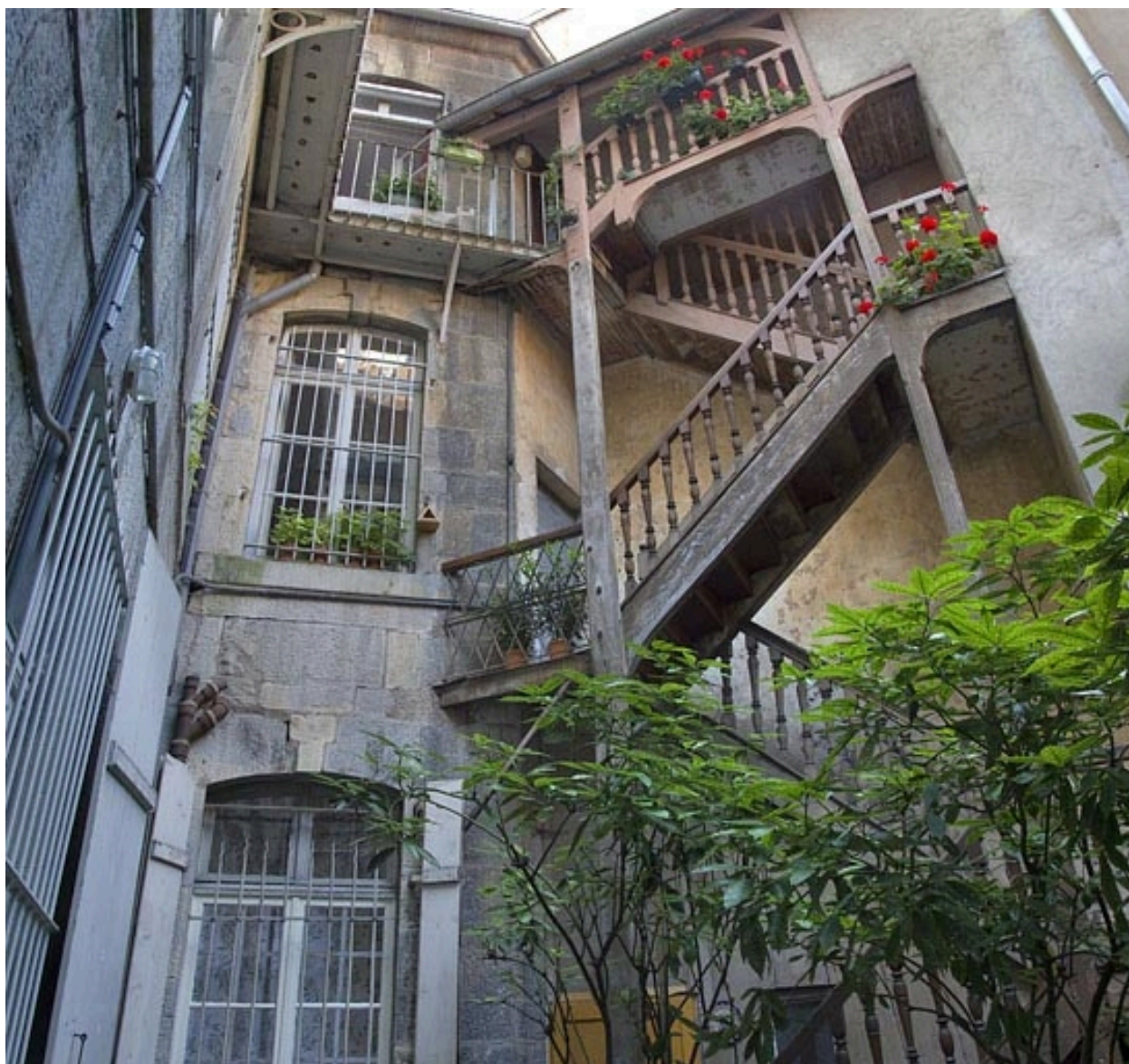
Vue d'ensemble de l'escalier à cage ouverte sur cour : de trois quarts droit.
