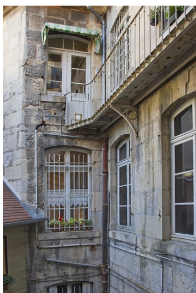
Logis : détail de la façade postérieure. Phot. Yves Sancey IVR43_20112501819NUC2A
