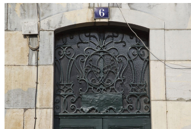
Façade antérieure : détail du dessus de porte en ferronnerie. Phot. Yves Sancey IVR43_20112501814NUC2A
