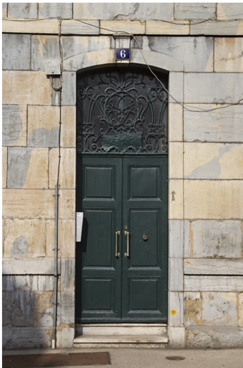
Façade antérieure : détail de la porte d'entrée.
