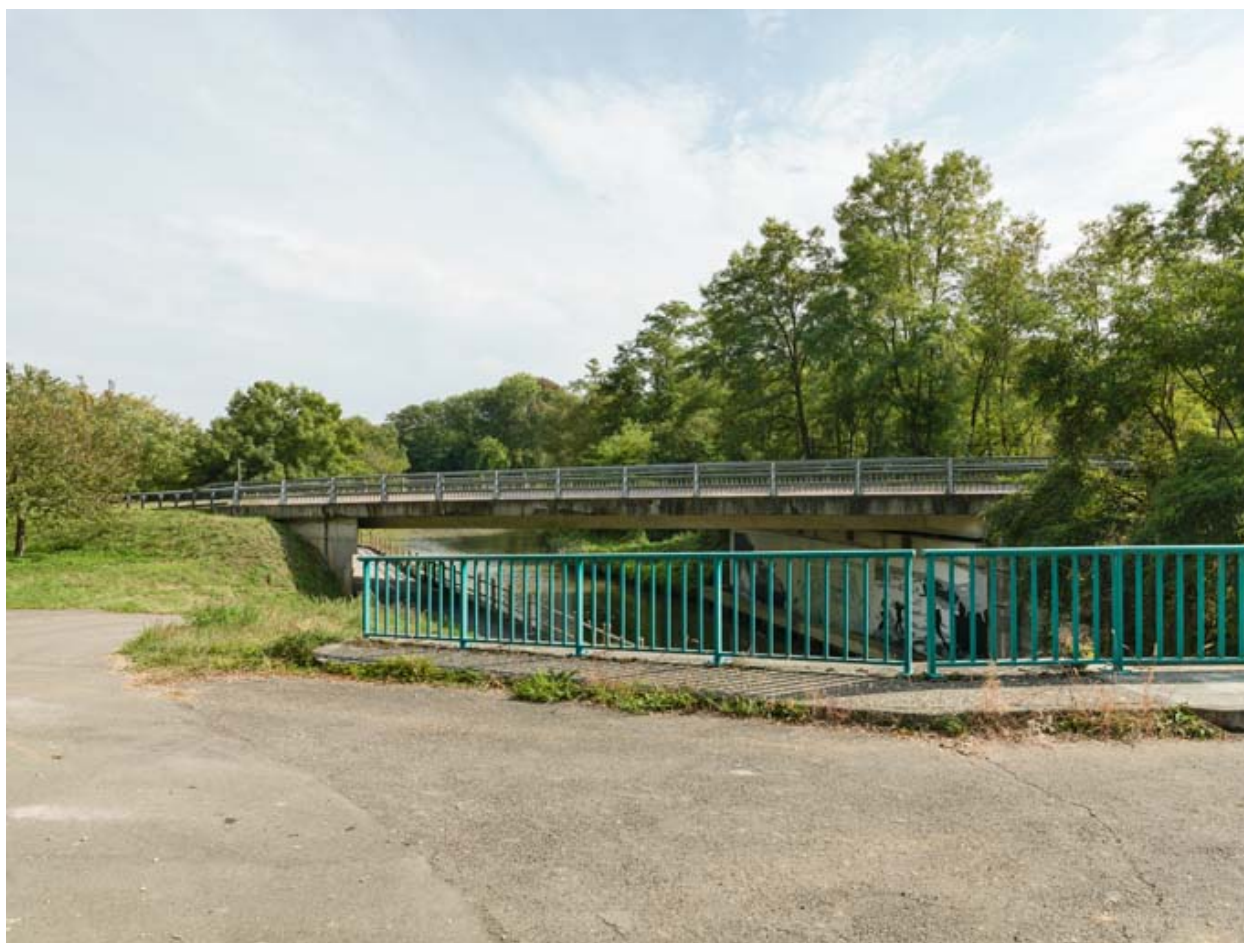
Vue d'ensemble du pont.
