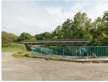
Vue d'ensemble du pont. Phot. Pierre-Marie Barbe-Richaud IVR26_20177100423NUC2A
