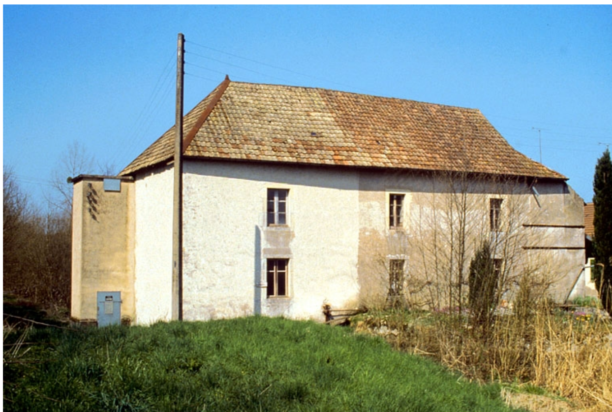
Façade latérale gauche, depuis le sud.
