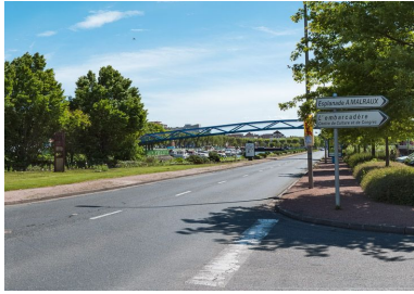
La passerelle avec le port. Phot. Pierre-Marie Barbe-Richaud IVR26_20137100425NUC4AQ
