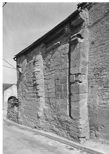
Façade sur rue. Phot. Michel Thierry IVR26_19748900089V
