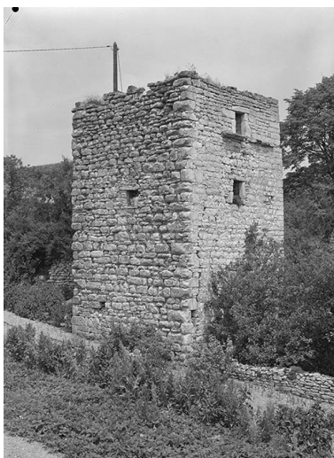
Tour carrée. Phot. Michel Thierry IVR26_19748900097V
