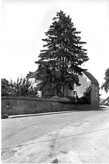
Vue d'ensemble depuis la rue. Phot. Bernard Lardière IVR43_19817000743Z
