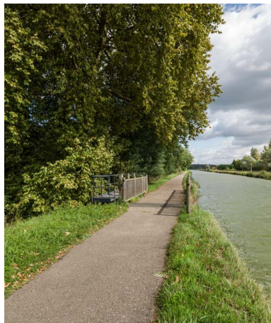
Vue du déversoir.
