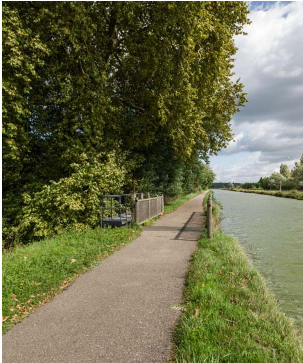
Vue du déversoir.
