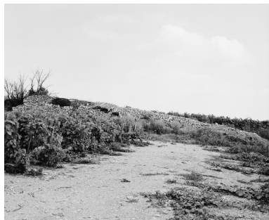
Vue d'ensemble du murger. Phot. Jean-Luc Duthu IVR26_19802100867X
