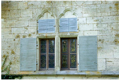
Détail : baies jumelées du 1er étage. Phot. Sonia Dourlot IVR43_20167000809NUC2A
