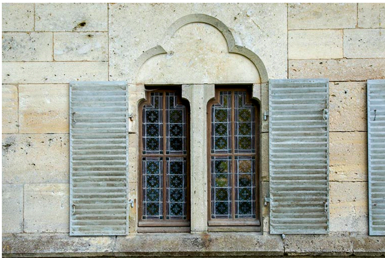
Détail : baie du rez-de-chaussée.
