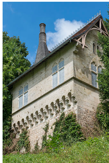
Vue générale de trois quarts montrant la tour, depuis le sud. Phot. Jérôme Mongreville IVR43_20177000891NUC4A
