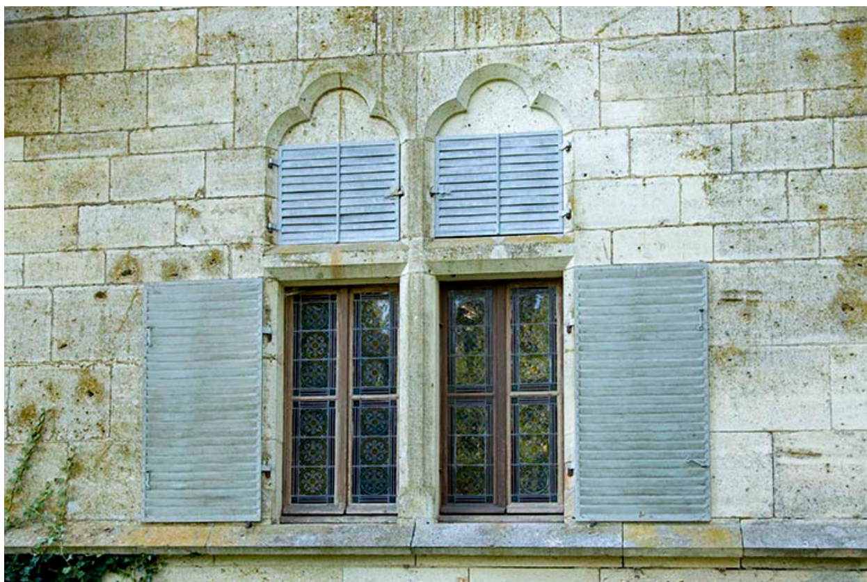
Détail : baies jumelées du 1er étage.
