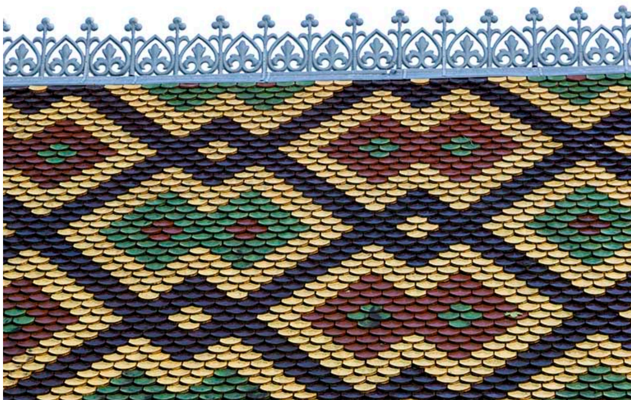
Détail : crête de toit.
