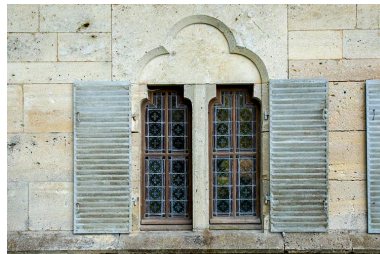
Détail : baie du rez-de-chaussée. Phot. Sonia Dourlot IVR43_20167000807NUC2A
