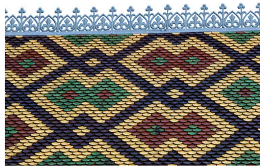
Détail : crête de toit. Phot. Sonia Dourlot IVR43_20167000806NUC2A
