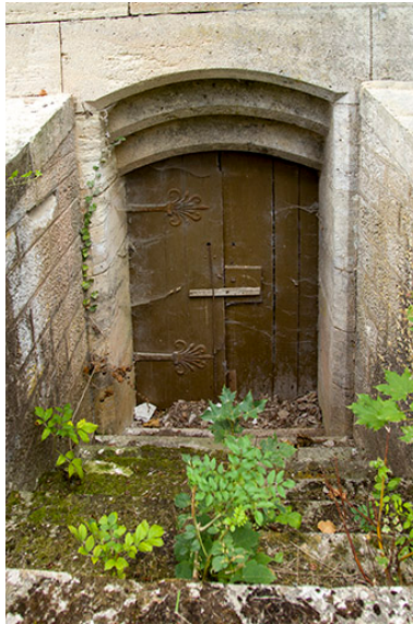
Détail : porte conduisant au sous-sol. Phot. Sonia Dourlot IVR43_20167000804NUC2A
