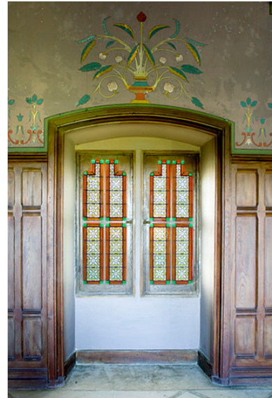
Intérieur : détail d'une des baies située au nord. Phot. Sonia Dourlot IVR43_20167000813NUC2A
