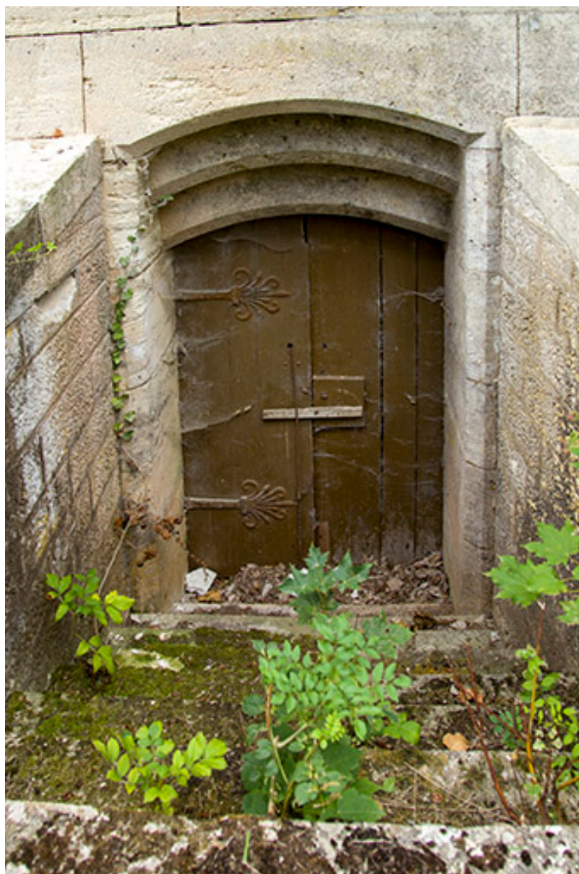
Détail : porte conduisant au sous-sol.
