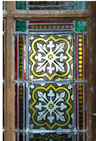
Détail d'une des verrières du rez-de-chaussée. Phot. Sonia Dourlot IVR43_20167000808NUC2A
