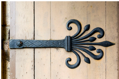
Détail ornemental de la porte d'entrée. Phot. Sonia Dourlot IVR43_20167000805NUC2A
