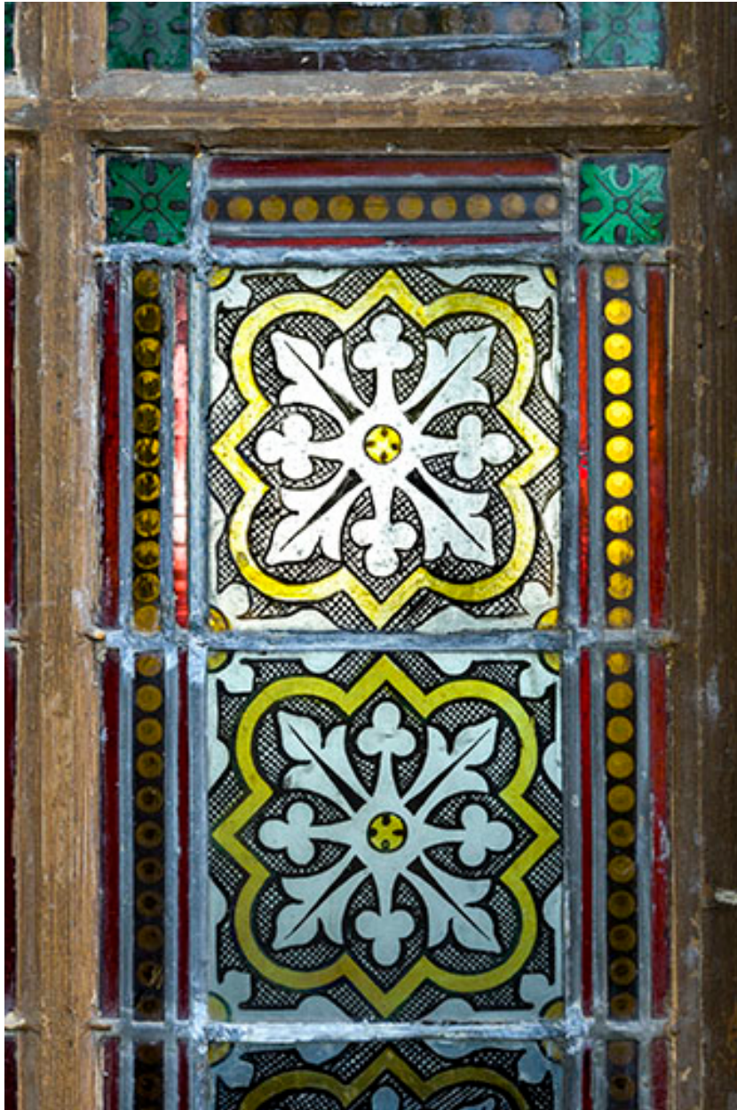
Détail d'une des verrières du rez-de-chaussée.
