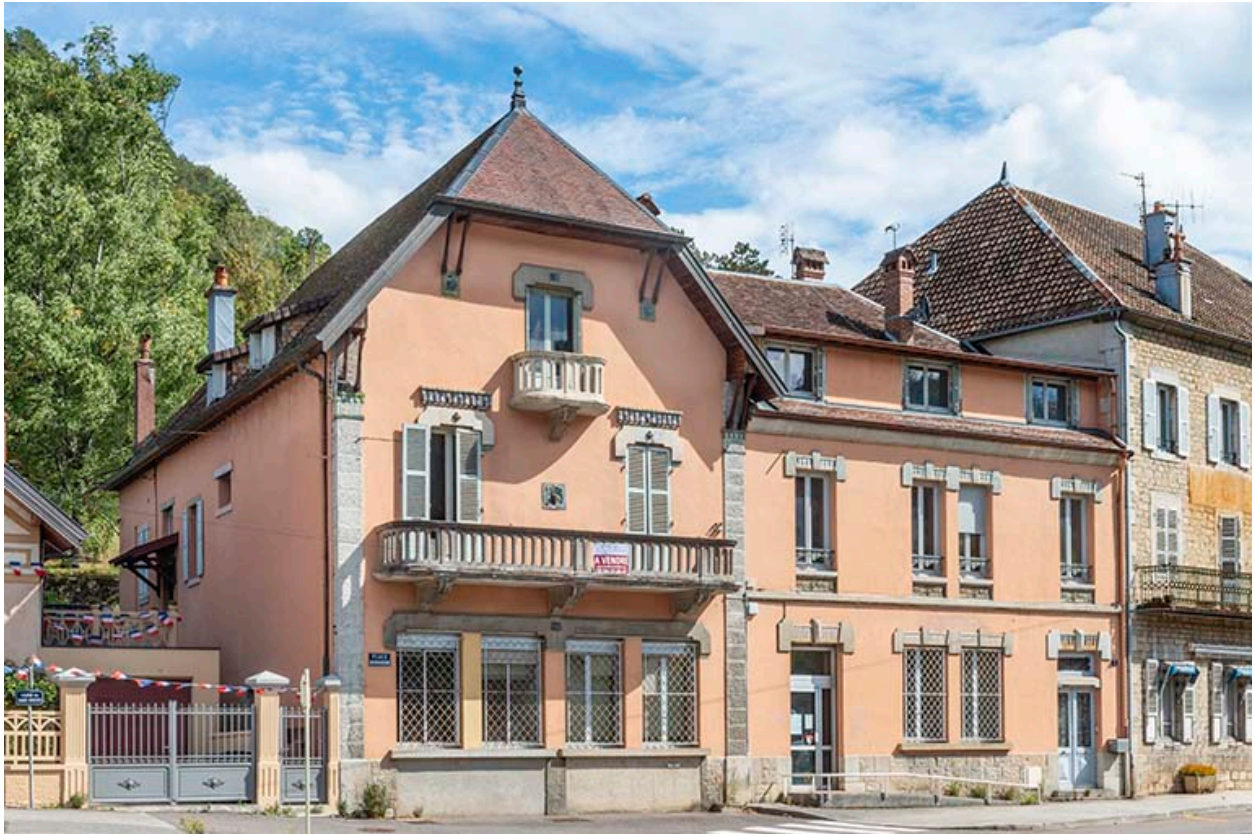
Partie nord vue de trois quarts.
