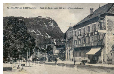
Salins-les-Bains (Jura) - Fort Saint-André - Place Aubarède, s.d. [début 20e siècle]. IVR43_20243901010NUC2A
