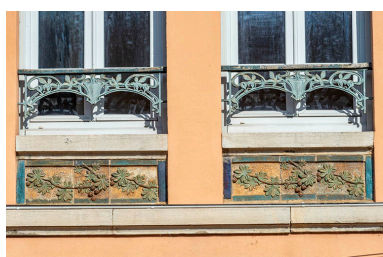
Façade nord. Détail des allèges de l'étage. Phot. Jérôme Mongreville IVR43_20243900587NUC4A
