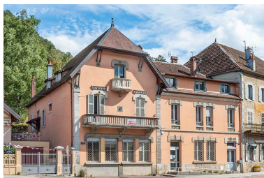
Partie nord vue de trois quarts. Phot. Jérôme Mongreville IVR43_20233900971NUC4A
