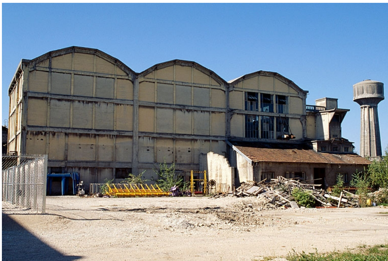
La centrale thermique depuis l'est.
