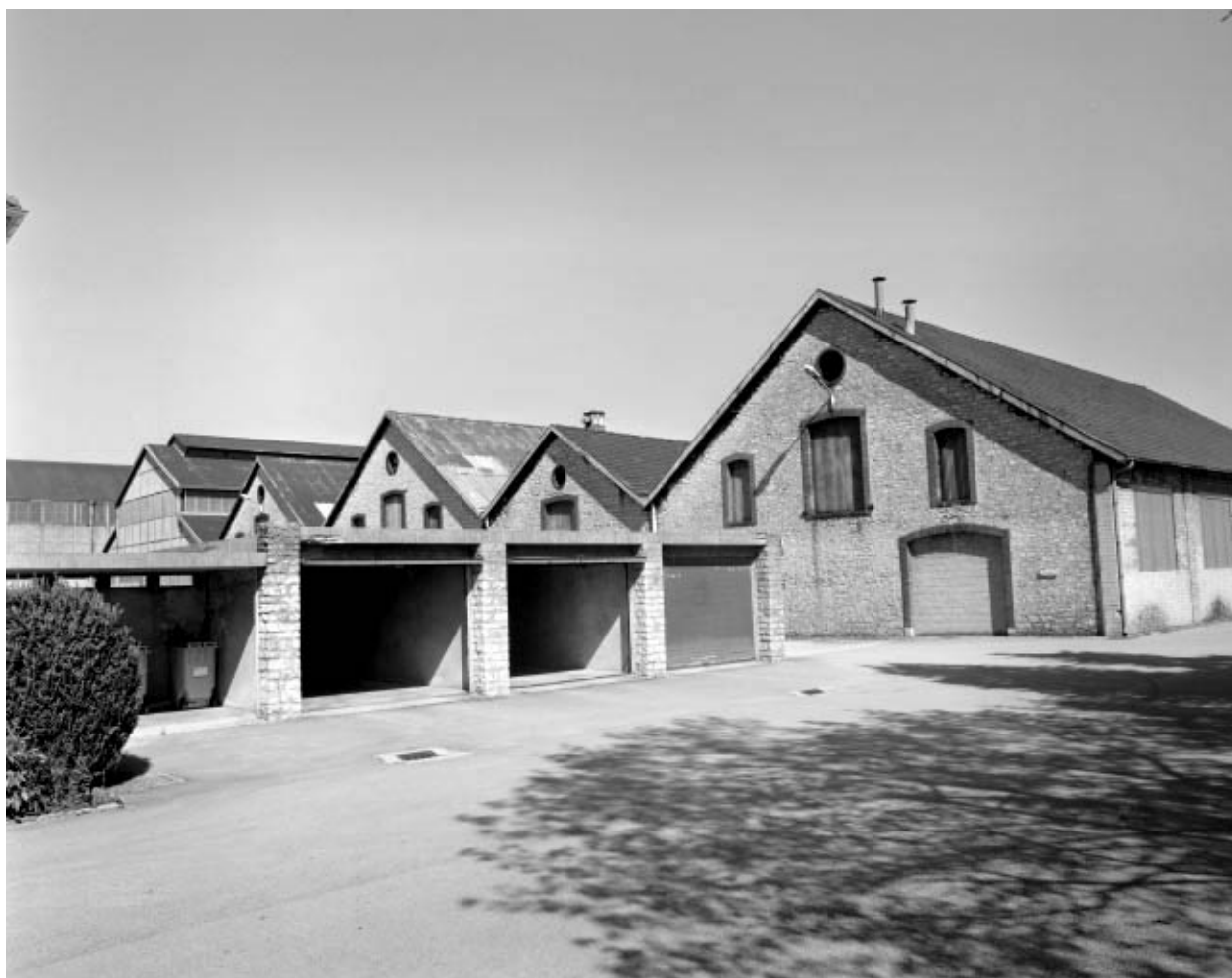
Pignons des ateliers de l'ancienne forge.
