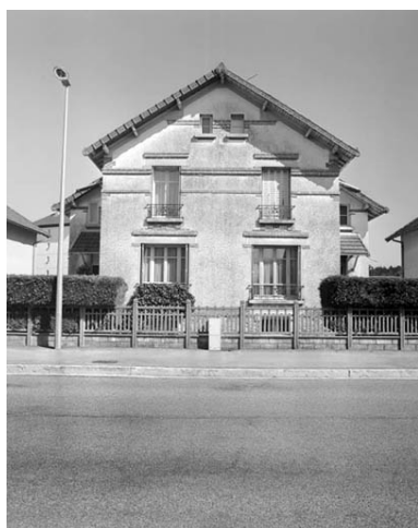
Façade antérieure d'un logement double (cadrage vertical). Phot. Yves Sancey IVR43_19973901543X
