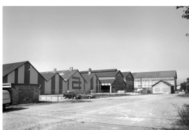
Façades postérieures des ateliers de l'ancienne forge. Phot. Yves Sancey IVR43_19973901516X
