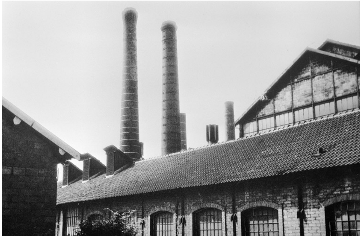
Façade postérieure du bâtiment des compresseurs.
