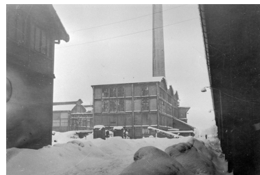
La centrale thermique depuis le sud-est. Phot. Jérôme Mongreville IVR43_19973901013X
