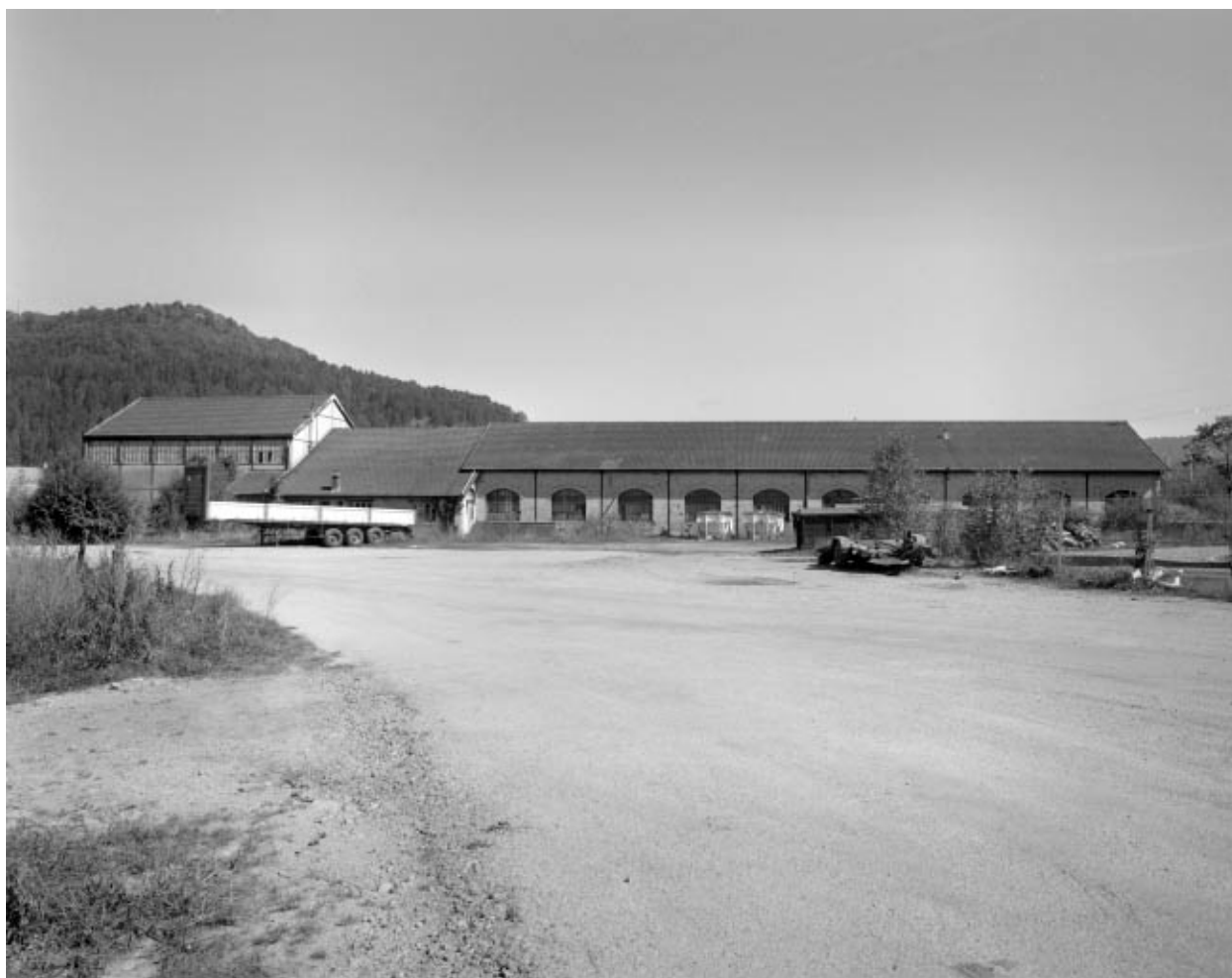
L'atelier de finition depuis l'ouest.
