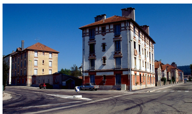
La cité ouvrière vue depuis l'ouest. Phot. Yves Sancey IVR43_19973901532ZA
