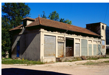
Le transformateur. Phot. Yves Sancey IVR43_19973901520ZA
