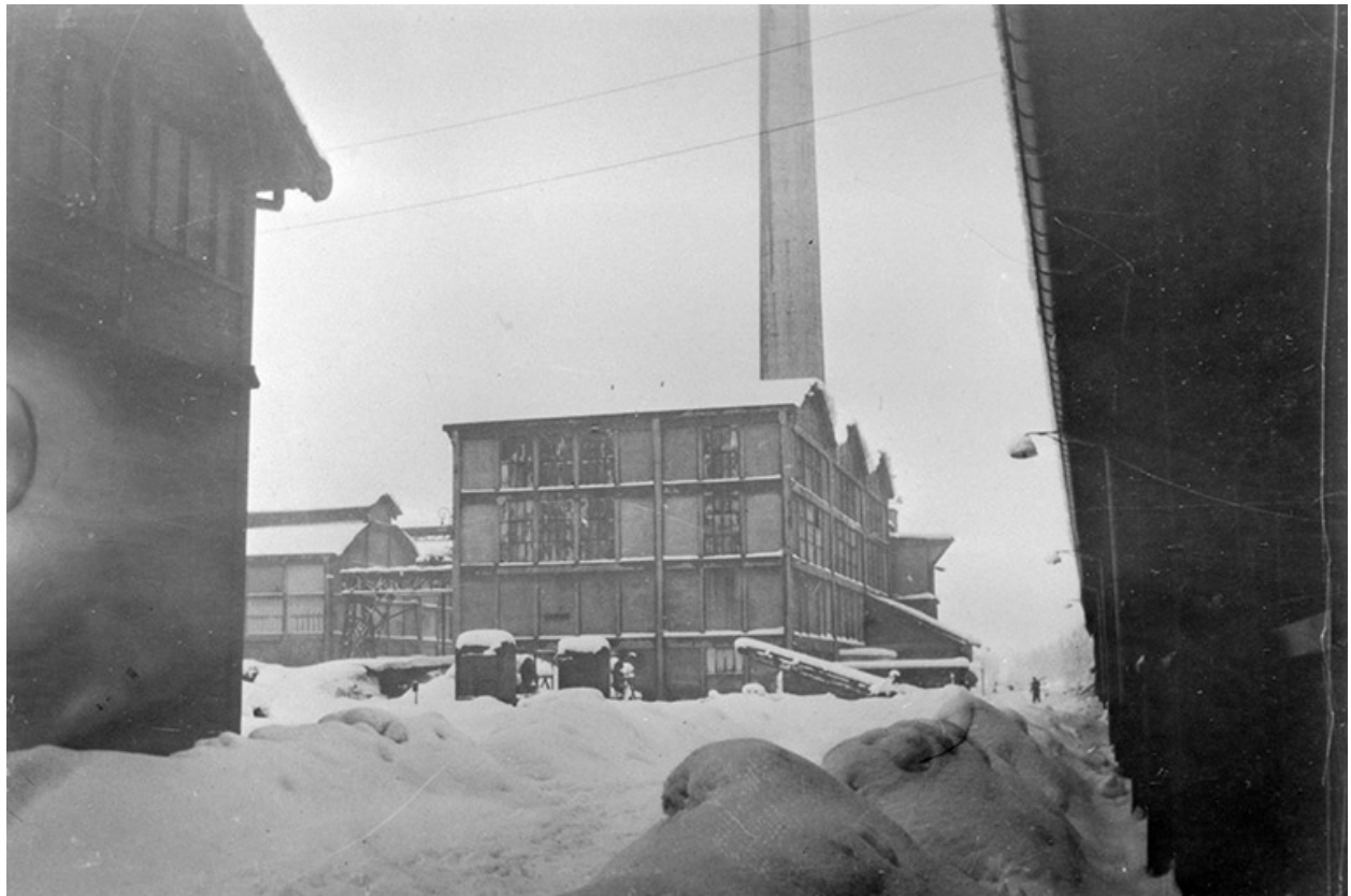
La centrale thermique depuis le sud-est.
