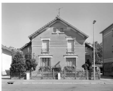
Façade antérieure d'un logement double (cadrage horizontal). Phot. Yves Sancey IVR43_19973901544X
