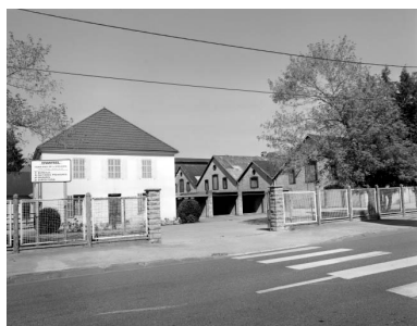
L'entrée des aciéries. De gauche à droite : bureaux et ateliers de l'ancienne forge. Phot. Yves Sancey IVR43_19973901507X
