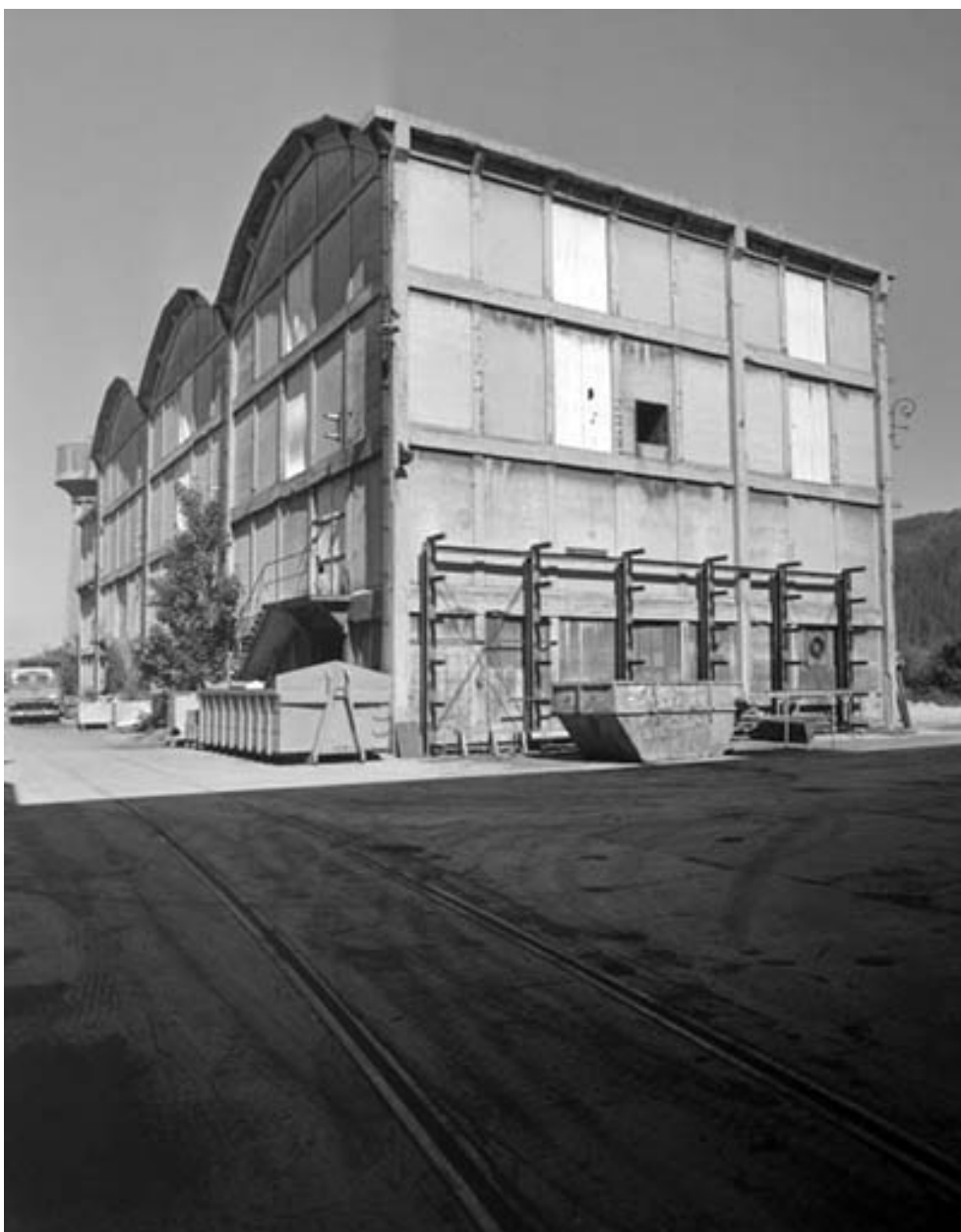
La centrale thermique vue de trois quarts.
