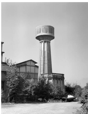
Le château d'eau.
