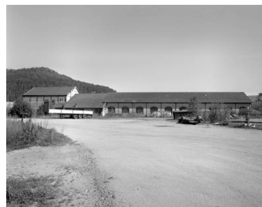
L'atelier de finition depuis l'ouest.
