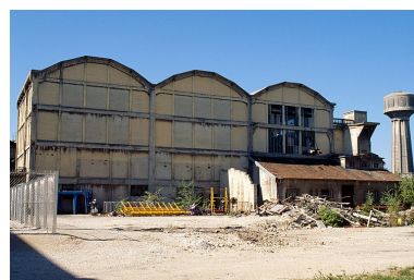
La centrale thermique depuis l'est.
