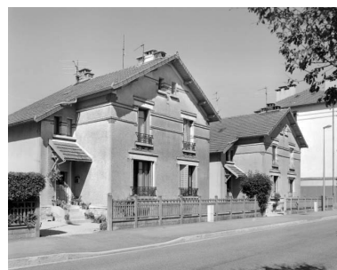
Logements doubles vus de trois quarts. Phot. Yves Sancey IVR43_19973901542X
