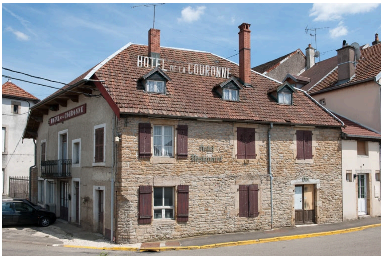
Façade antérieure et latérale droite.
