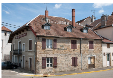
Façade antérieure et latérale droite.
