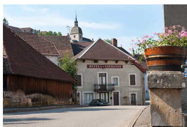
Vue générale éloignée.
