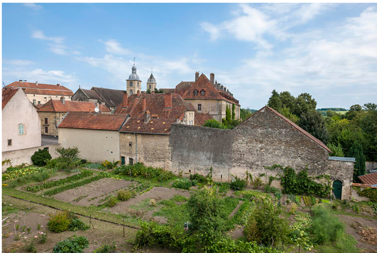
Vue générale depuis la rue Rollin
