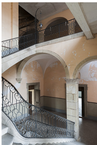
Intérieur : la montée du grand escalier. Phot. Mary Ruffinoni IVR43_20137000044NUC4A
