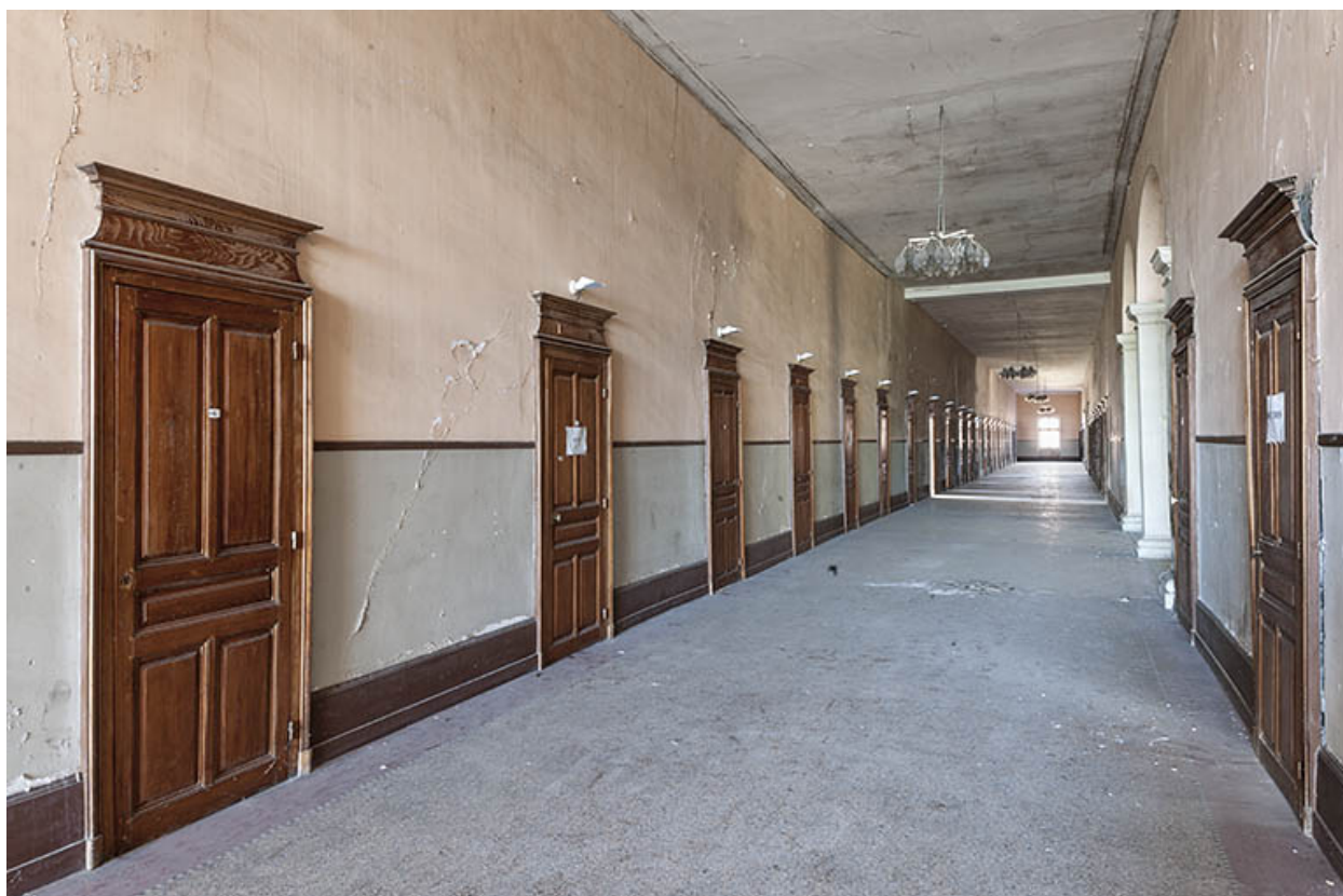
Intérieur : le couloir en direction de l'ouest.
