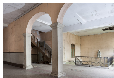
Intérieur : le grand escalier au rez-de-chaussée. Phot. Jérôme Mongreville IVR43_20137000047NUC4A
