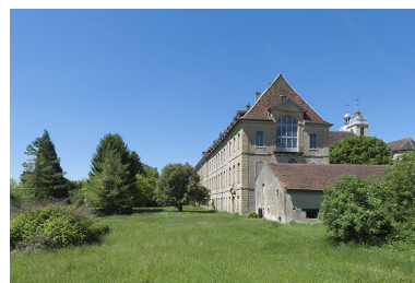
Aile sud depuis l'entrée, rue de l'Abbaye. Phot. Mary Ruffinoni IVR43_20127000341NUC4A
