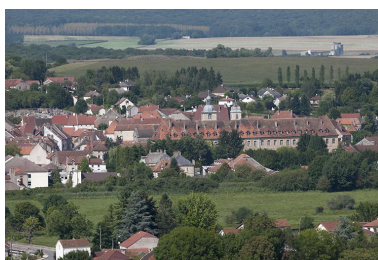
Vue générale depuis le sud. Phot. Jérôme Mongreville IVR43_20127000589NUC4A
