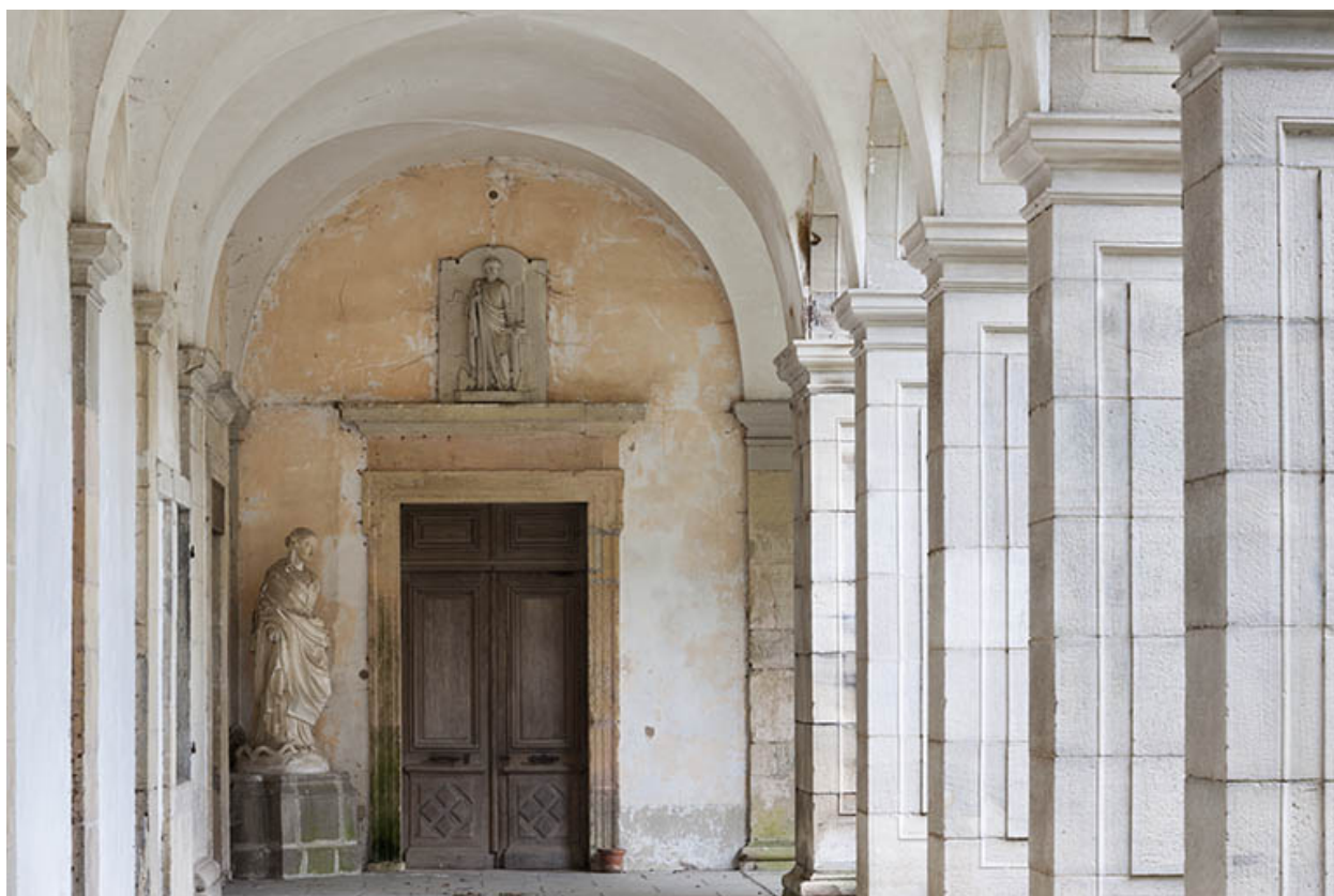
Vue rapprochée de la galerie sud.
