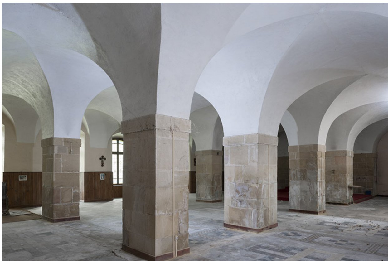
Intérieur : l'étage de soubassement.
