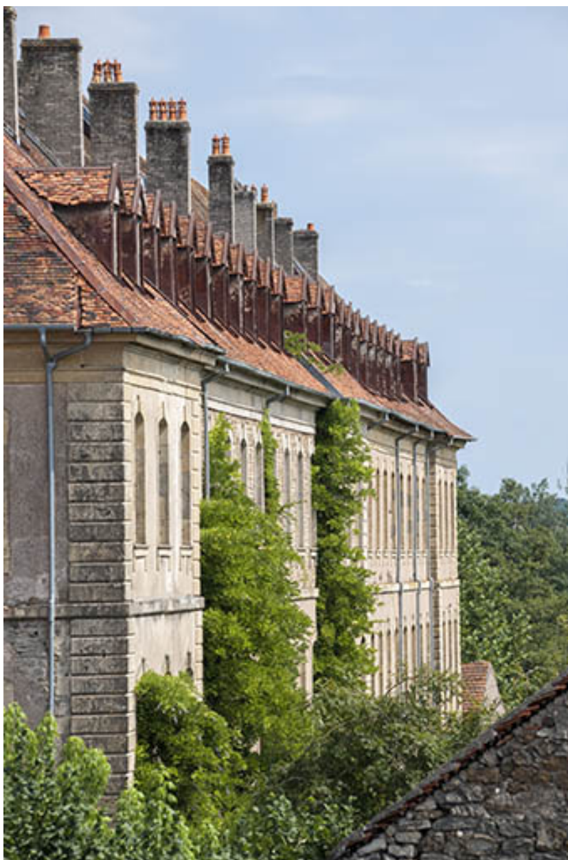
Vue rapprochée de la façade sud.
