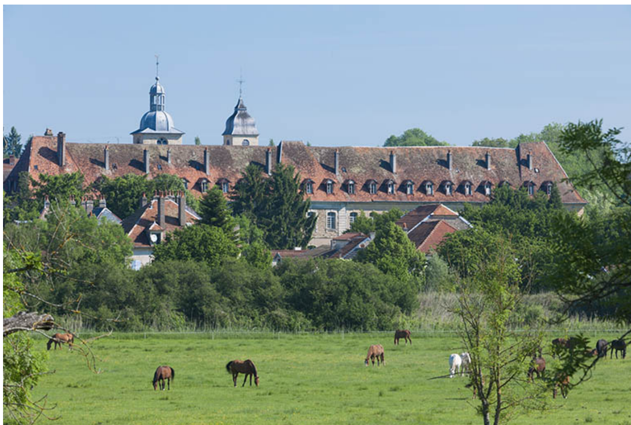
Vue générale rapprochée depuis le sud.
