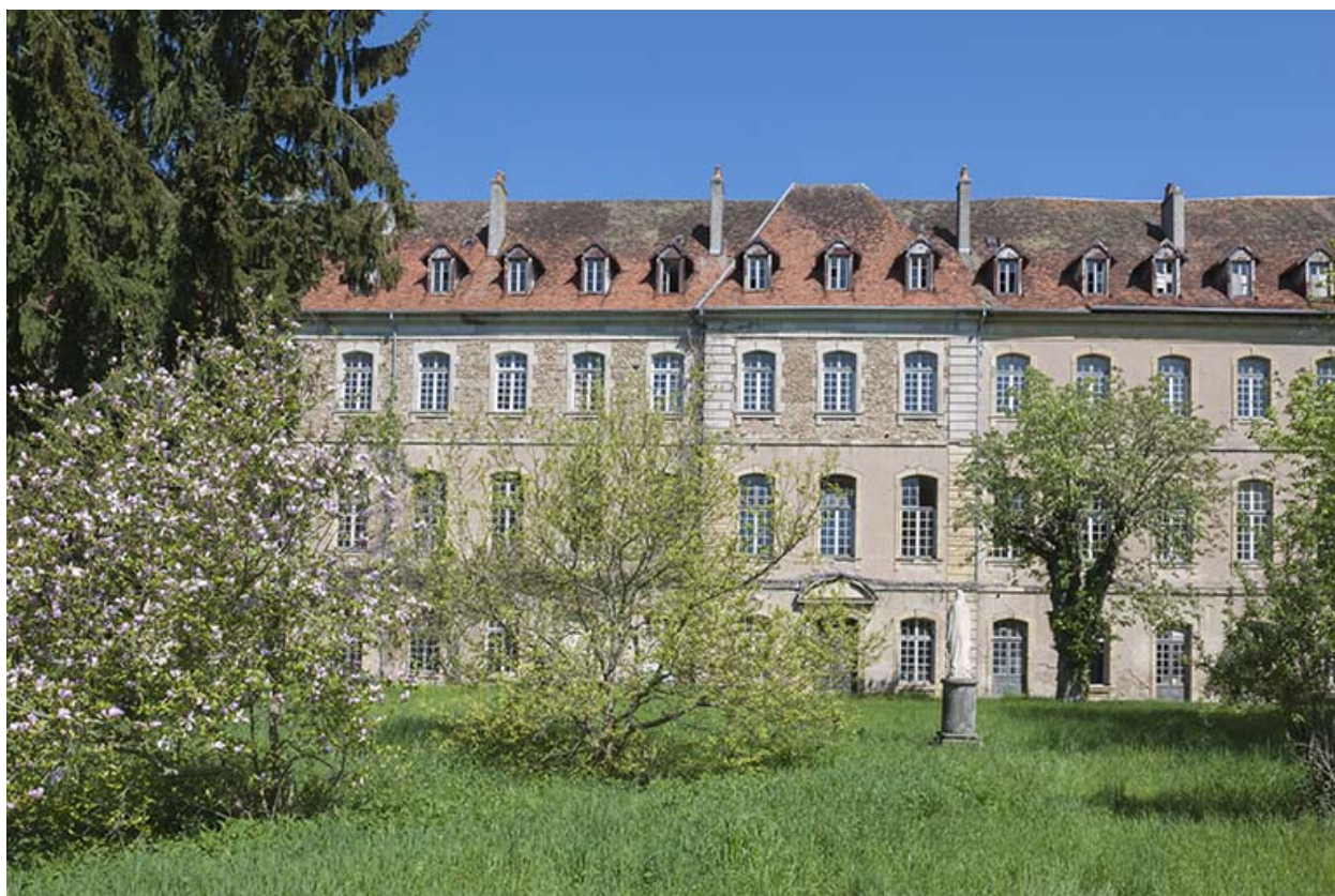
Façade sud vue de face.
