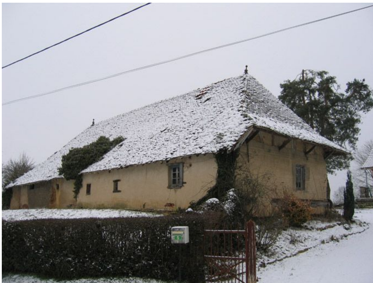
Vue d'ensemble de la façade.
