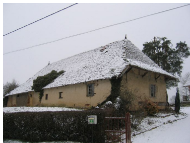
Vue d'ensemble de la façade.
