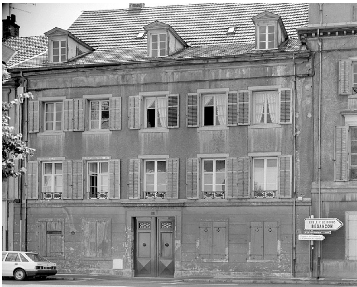
Façade principale sur rue.
