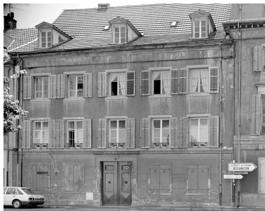
Façade principale sur rue. Phot. Jérôme Mongreville IVR43_19882500124V
