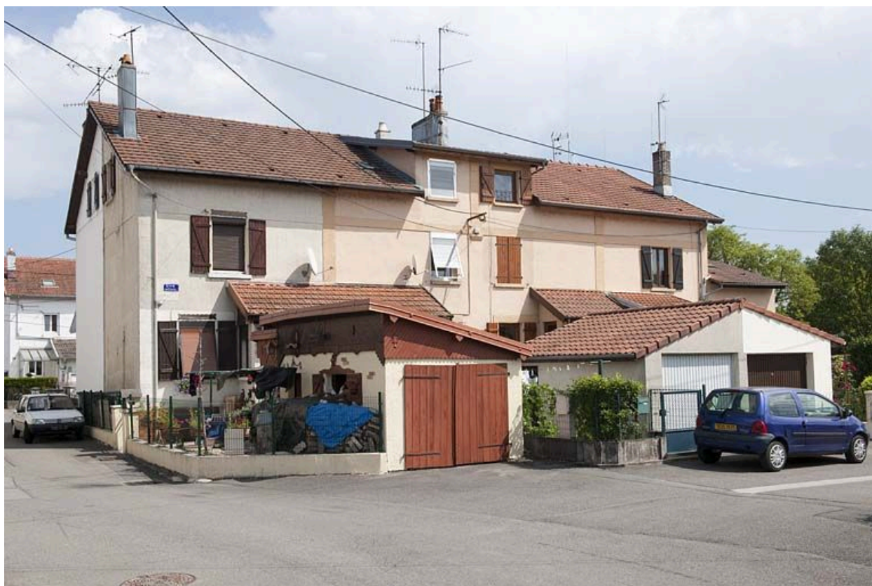
Habitation à 8 logements. Façade ouest.
