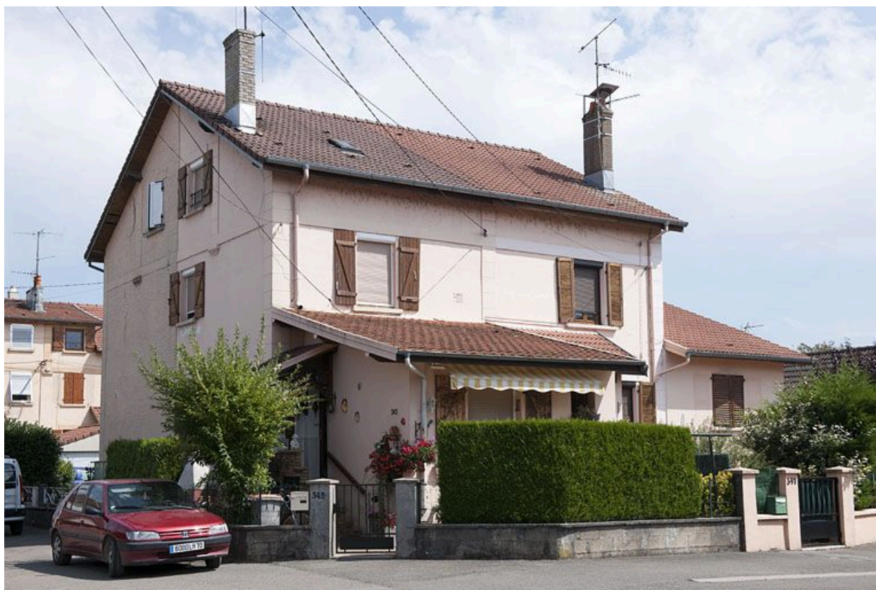
Habitation à 4 logements. Façade ouest.
