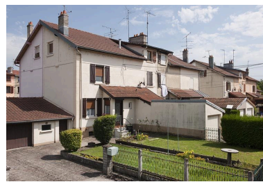
Habitations à 8 logements. Façades sur jardins. Phot. Jérôme Mongreville IVR43_20112502050NUC4A
