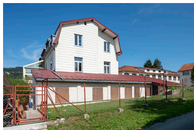
Façade latérale droite et atelier de fabrication. Phot. Sonia Dourlot IVR43_20182501237NUC4A
