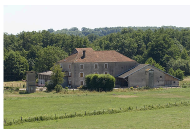
Vue d'ensemble depuis le nord-ouest. Phot. Jérôme Mongreville IVR43_20067000624NUCA
